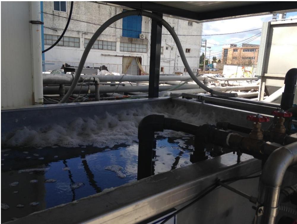
Εικόνα 30. Δημιουργία αφρών κατά την εκκίνηση της λειτουργίας του φυσητήρα
