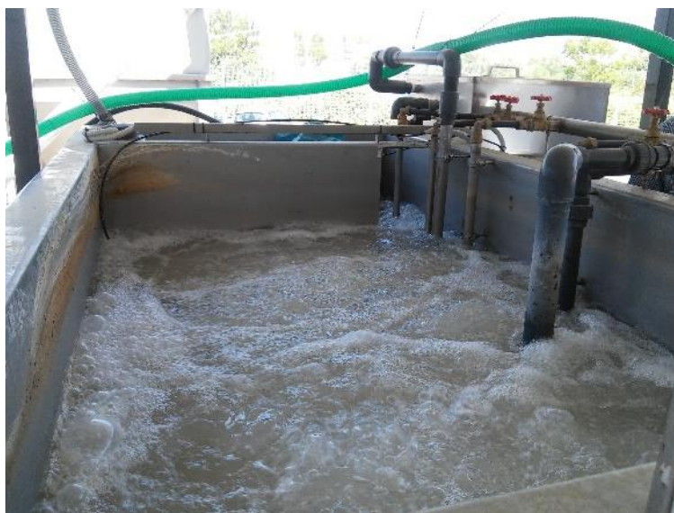
Εικόνα 33. Τροφοδοσία αερόβιου διαμερίσματος με υγρά απόβλητα
