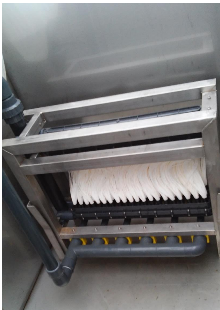
Εικόνα 10. Μονάδα μεμβρανών βιομηχανίας τροφίμων
