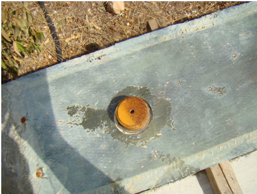
Εικόνα 7.1: Τοποθέτηση μεταλλικού εξαρτήματος για τη δοκιμή εξόλκευσης
