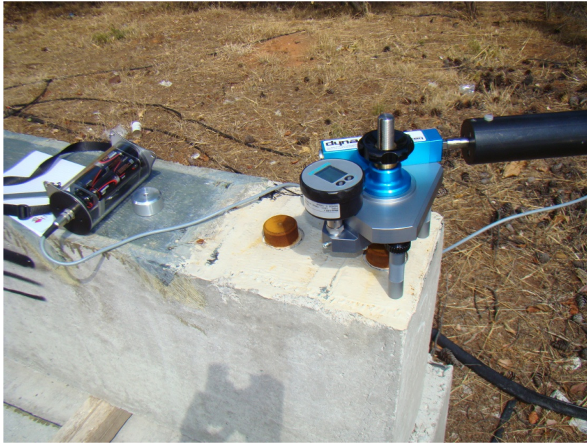
Εικόνα 7.3: Διάταξη μηχανήματος και εξαρτημάτων δοκιμής εξόλκευσης
