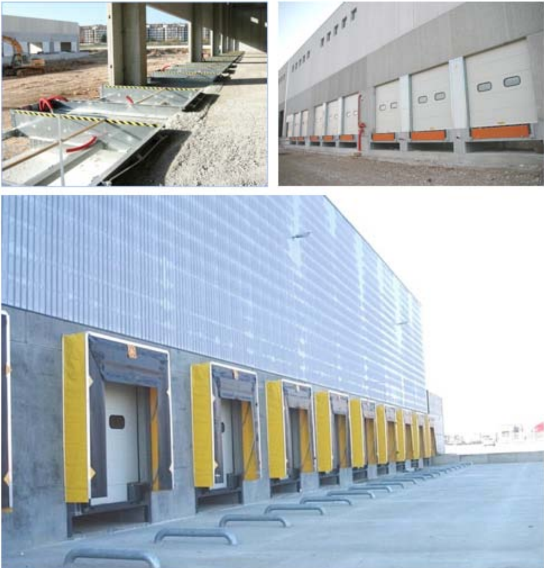
Σχήμα 8.4 : Τεχνικές εξοικονόμησης ενέργειας στις ράμπες παραλαβοαποστολών ψυχόμενης αποθήκης 31
