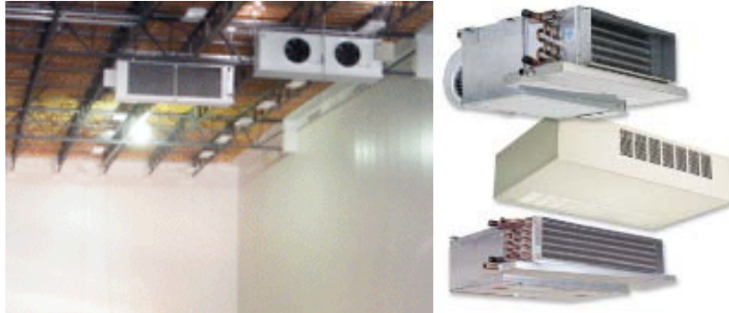
Σχήμα 7.2 : Fan coils για τις ανάγκες θέρμανσης/ψύξης 79
