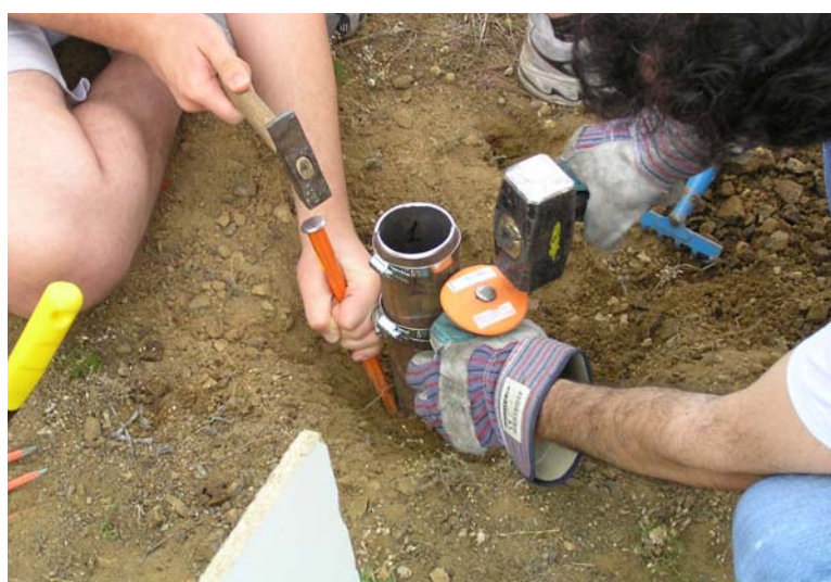
Σχήμα 3.7 Διαδικασία εξαγωγής του σωλήνα από το έδαφος
