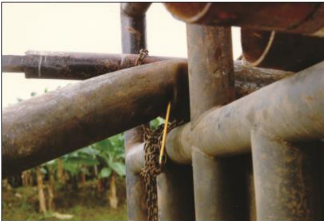
Εικόνα 3.1: Ρήξη τοιχώματος σωλήνα με αγωγό υγρού καυσίμου (Limon, Costa Rica, 1991)
