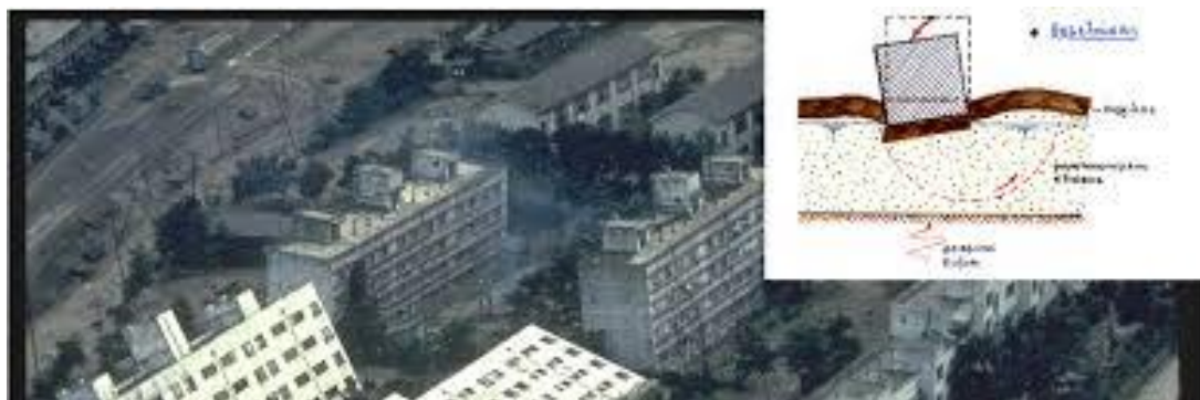
Εικόνα 2.7: Ρευστοποίηση εδάφους μετά από σεισμό στην Ιαπωνία το 1964
