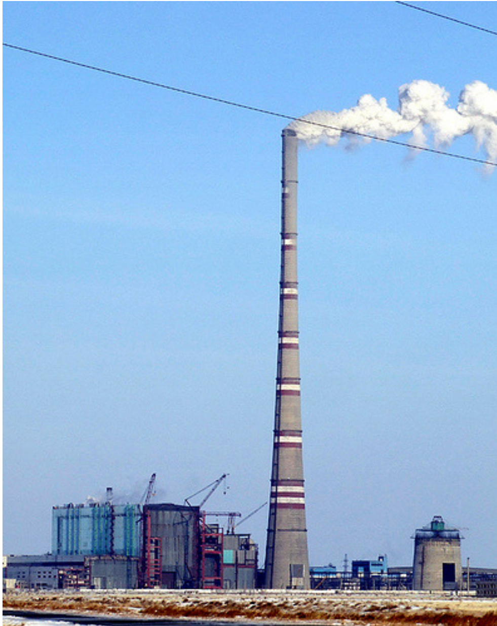
Εικόνα 1.1: Καπνοδόχος στον ηλεκτροπαραγωγό σταθμό GRES-2 - Καζακστάν (GRES-2 Power Plant). [3]
