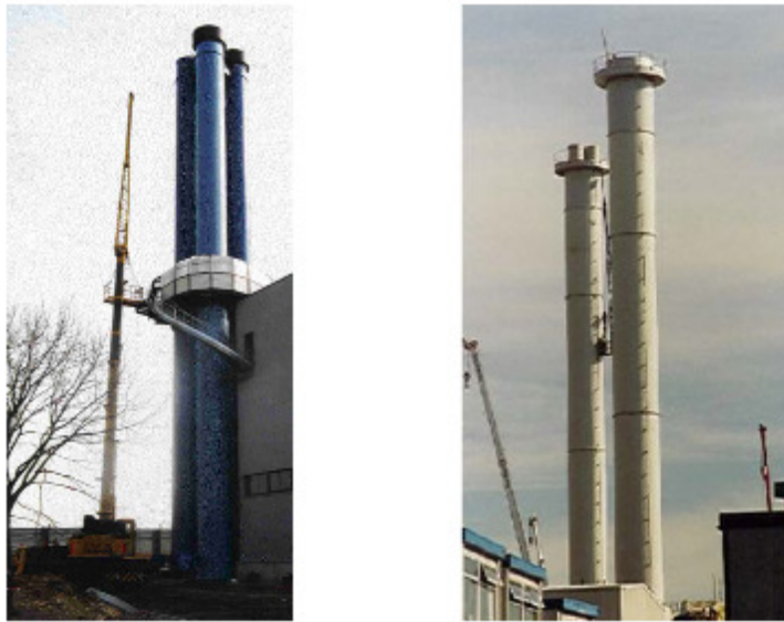
Σχήμα 8.6: (α) Αποσβεστήρας TLD's τοποθετημένος στο κέντρο ομάδας καπνοδόχων (β) Αποσβεστήρας TLD's τοποθετημένος στη άνω πλατφόρμα της καπνοδόχου
