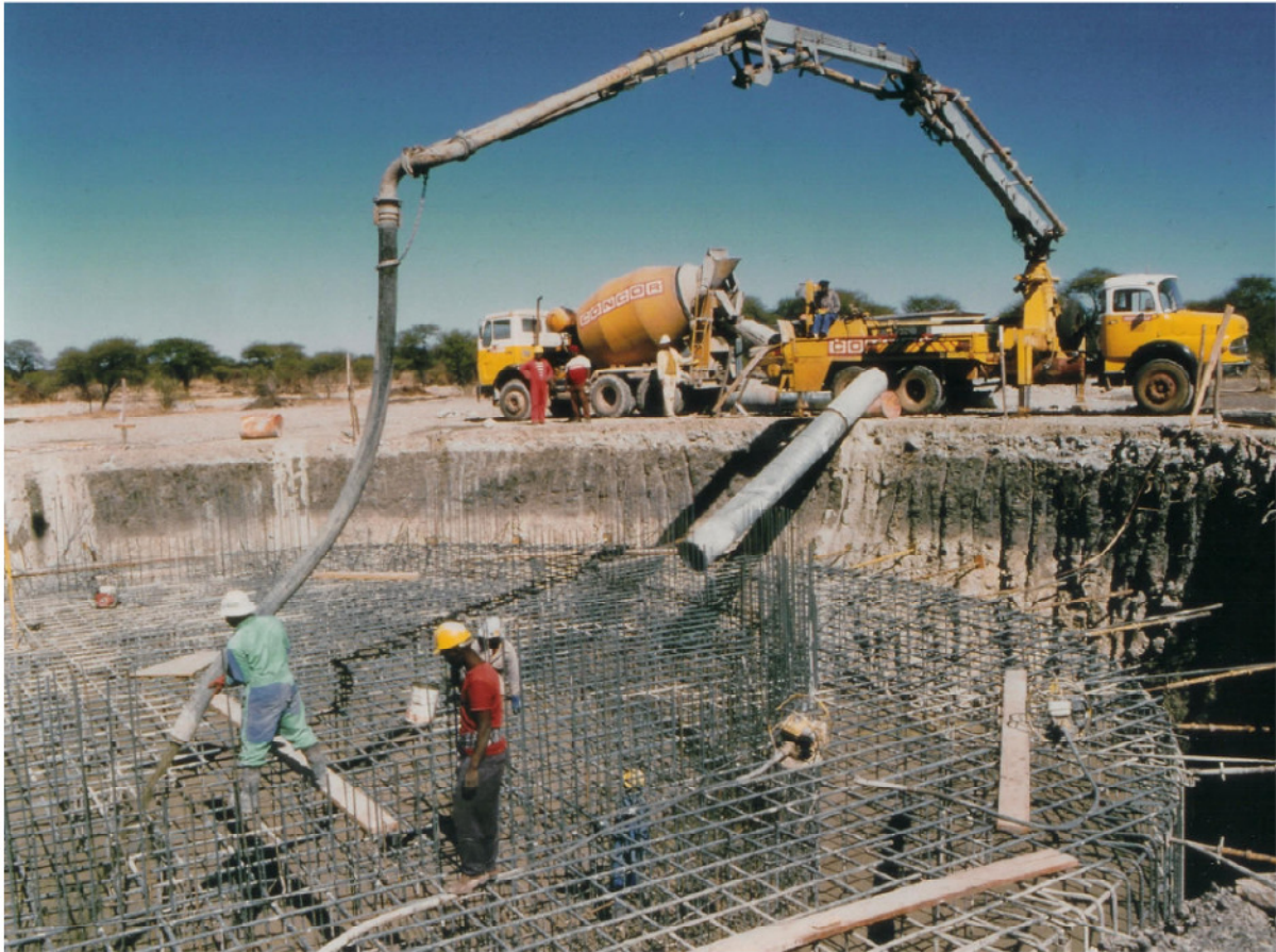
Εικόνα 3.1: Κατασκευή θεμελίωσης 200m καπνοδόχου στην Νότια Αφρική.
