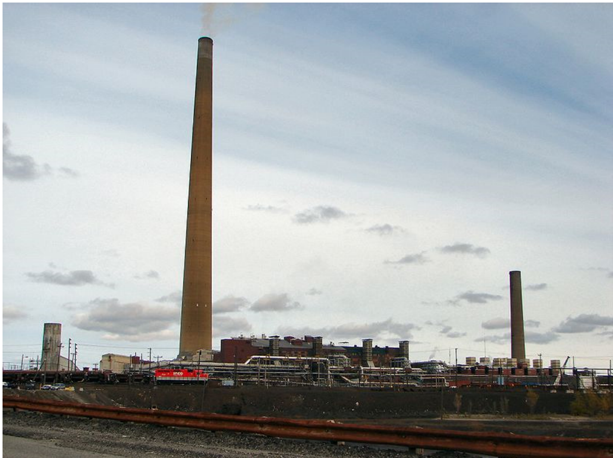
Εικόνα 1.3: Καπνοδόχος "Inco Superstack" στο εργοστάσιο μεταλλουργίας χαλκού "Inco Copper Cliff".- Καναδά [3]
