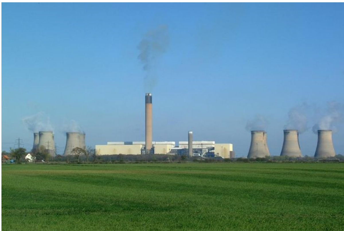
Εικόνα 1.5: Καπνοδόχος στον ηλεκτροπαραγωγό σταθμό "Drax" – Ηνωμένο Βασίλειο. [3]
