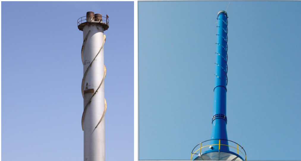
Σχήμα 8.3: Καπνοδόχος με σπειροειδή αεροτομή για μείωση του εύρους εγκάρσιας ταλάντωσης λόγω στροβιλώδους διέγερσης.
