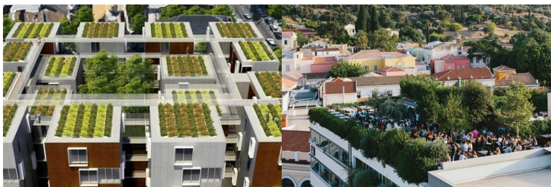
Σχήμα 4.3. <<Πράσινες ταράτσες>>. Βλάστηση στις οροφές κτηρίων.
