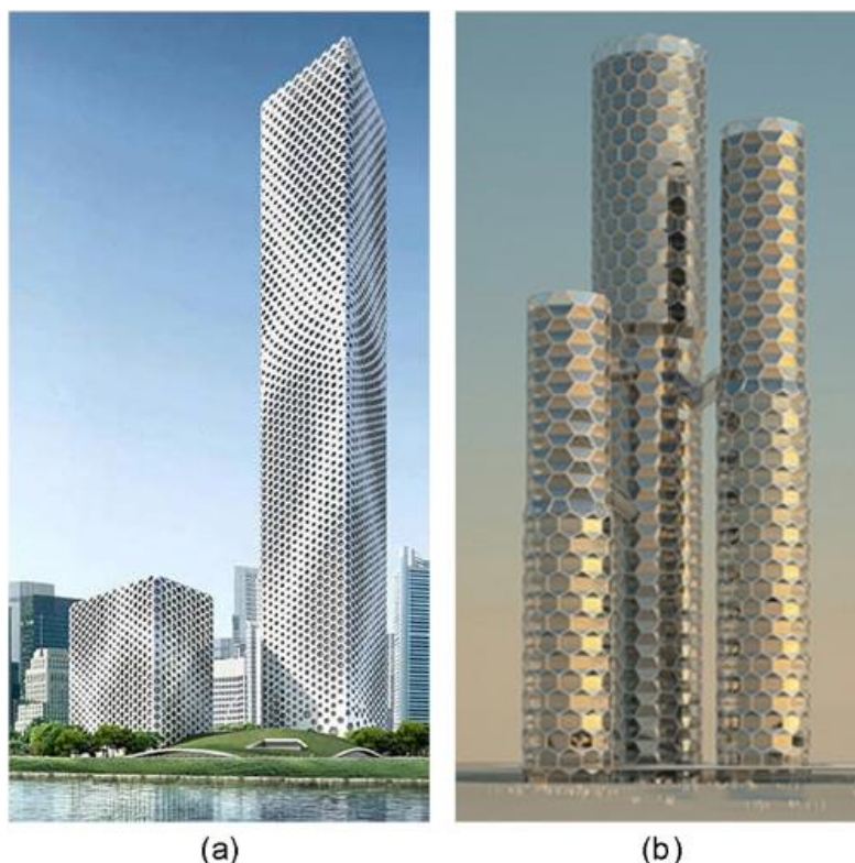
Σχήμα 1.14. Ουρανοξύστης (Sinosteel) υπο κατασκευή στην πόλη Tianjin της Κίνας (a), ουρανοξύστες (Nanotower) στο Ντουμπάι (b) (Montuori et al., 2015)
