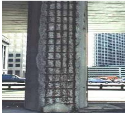
Εικόνα 4.2 Διάβρωση οπλισμού
