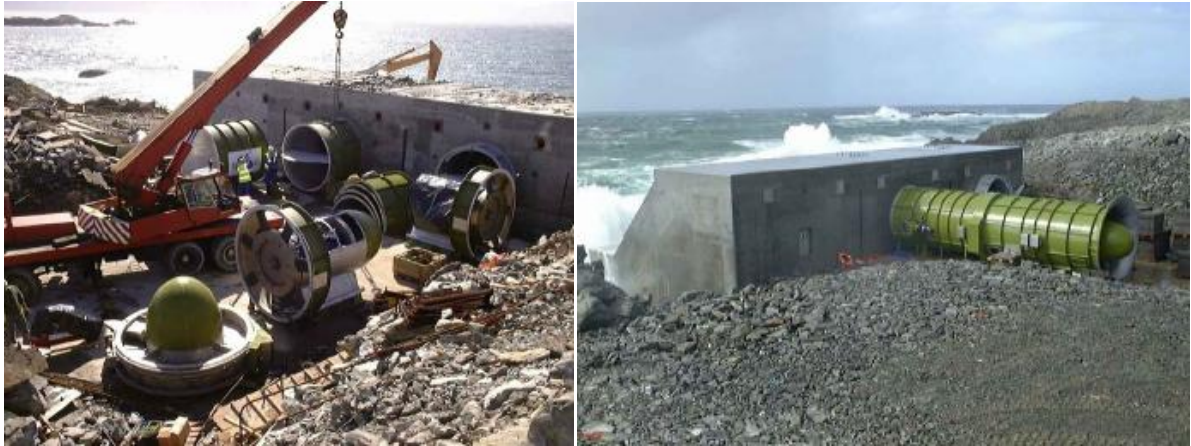
Εικόνα 47 : Η μονάδα LIMPET κατά την κατασκευή (αριστερά) και η ολοκληρωμένη κατασκευή (δεξιά) [81]
