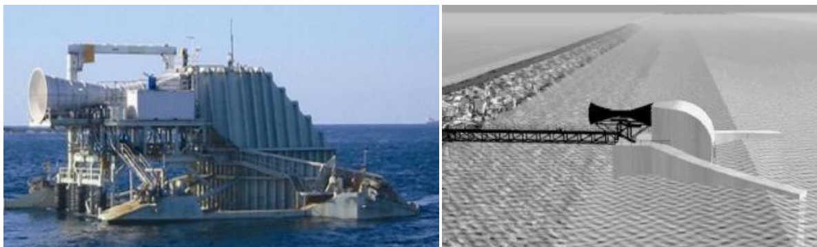
Εικόνα 62 : Η πακτωμένη μονάδα ΠΣΥ με τοιχώματα συντονισμού, της Oceanlinx (ή Energetech), 2005 (αριστερά) [86] και ένα καλλιτεχνικό σχέδιο της (δεξιά) [46]
