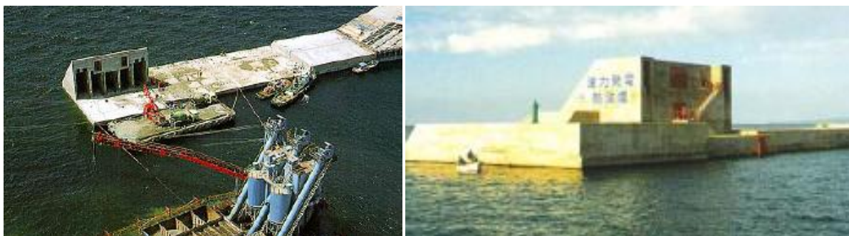
Εικόνα 55 : Η μονάδα ΠΣΥ στο λιμάνι Sakata της Ιαπωνίας κατά την περίοδο κατασκευής της (Αριστερά) & κατά την φάση λειτουργίας της (δεξιά) [27] [83]
