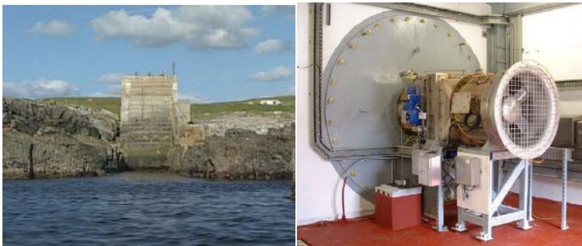
Εικόνα 46 : Η μονάδα των 75 kW του Παν/μιου του Belfast (αριστερά) και ο στρόβιλος της κατασκευής (δεξιά) [73]
