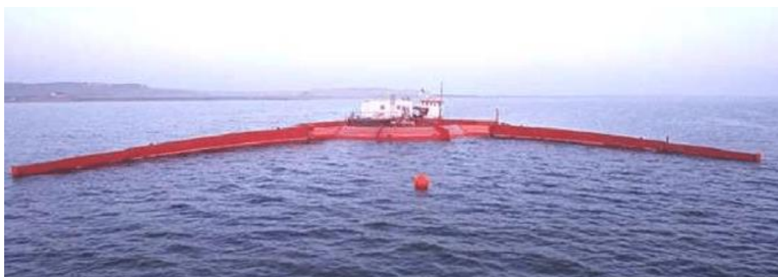
Εικόνα 31 : Η πιλοτική κατασκευή Wave Dragon που βρίσκεται 1,7 km έξω από την ακτή Pembrokeshire στην Ουαλία (Ηνωμένο Βασίλειο)
