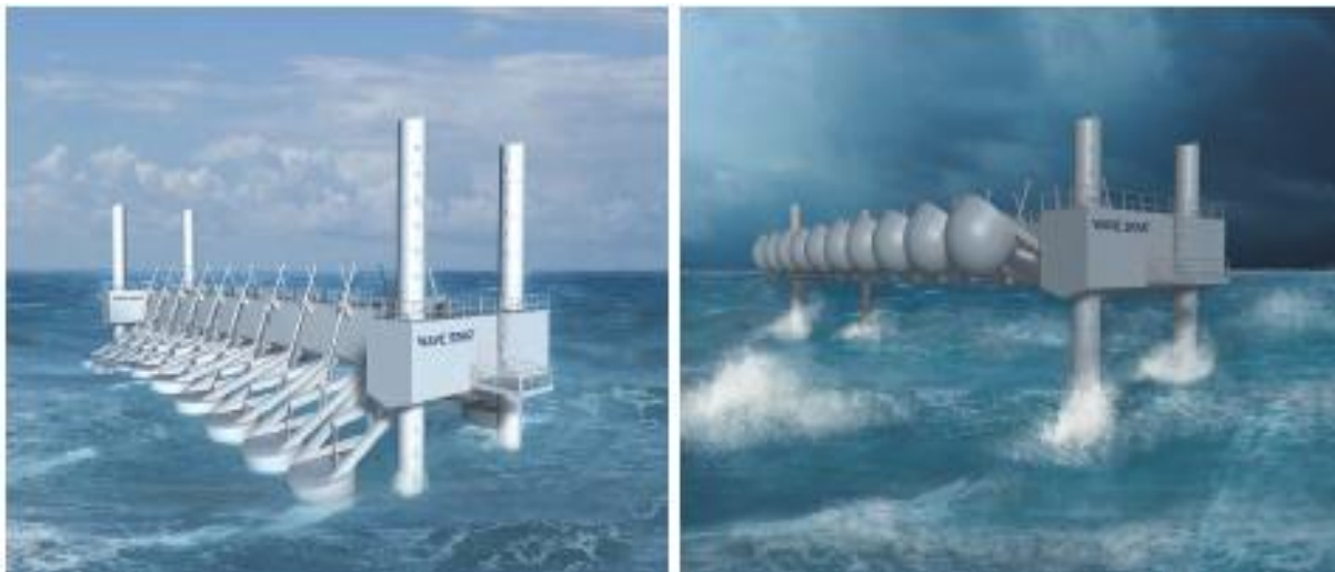
Εικόνα 27 : Σχήμα προσομοίωσης της κατασκευής Wavestar σε κατάσταση λειτουργίας (αριστερά) και σε κατάσταση παύσης λόγω καταιγίδας (δεξιά) [63]
