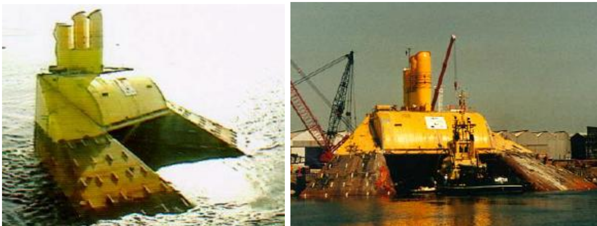
Εικόνα 58 : Η συσκευή OSPREY 1 κατά την διάρκεια της κατασκευής της [83]
