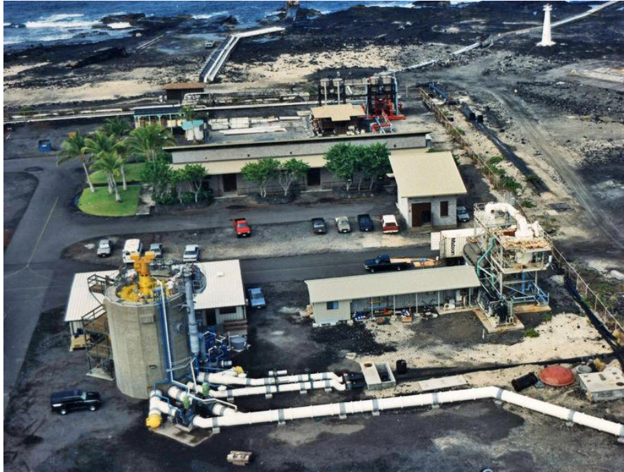
Εικόνα 7: Μια εγκατάσταση εκμετάλλευσης ωκεάνιας θερμικής ενέργειας που βρίσκεται στο Keahole Point στην Hawaii.
