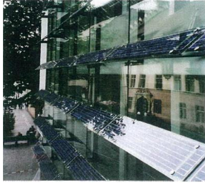
Εικόνα 2-23 σκίαστρα φωτοβολταϊκών με εμφανή προβλήματα από παρακείμενη σκίαση
