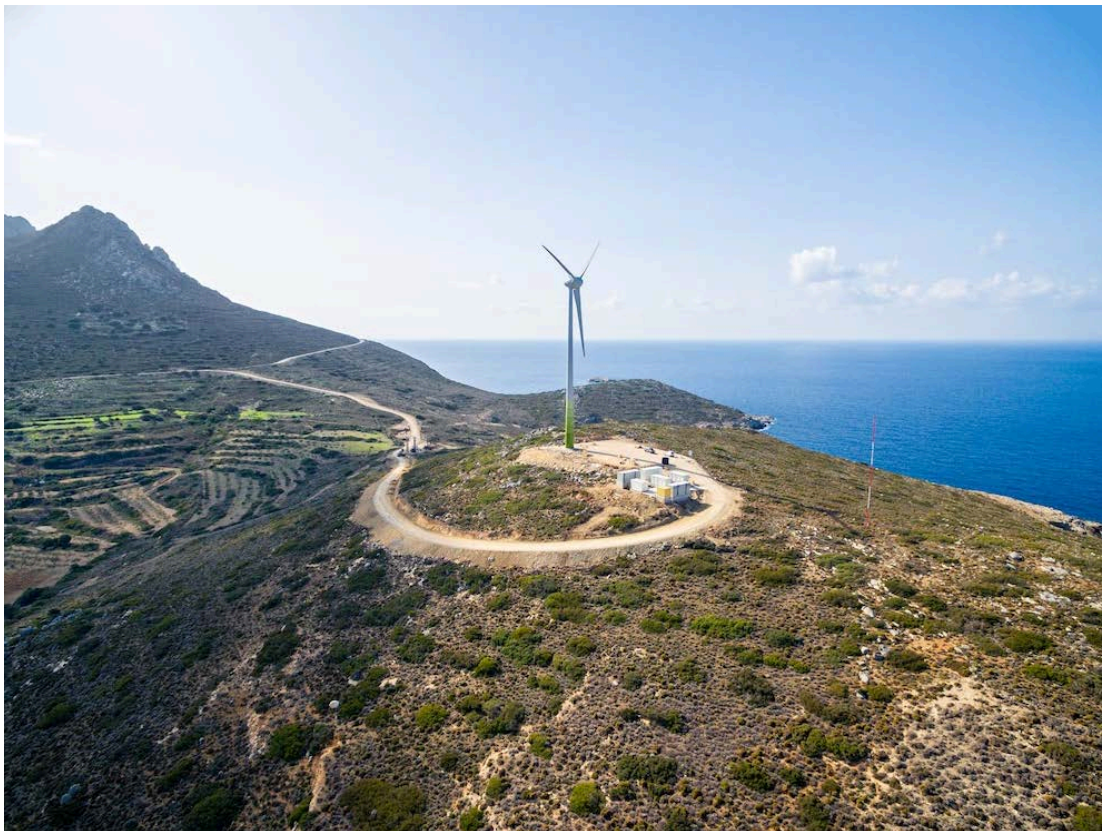
Εικόνα 3.3: Πανοραμική άποψη Ανεμογεννήτριας και Συσσωρευτών ΥΒΣ Τήλου
