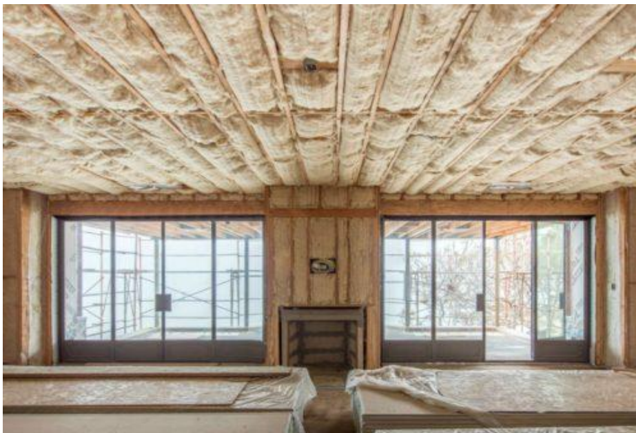
Εικόνα 3.7: Μόνωση με μαλλί σε δωμάτιο. (πηγή: www.constructionspecifier.com )
