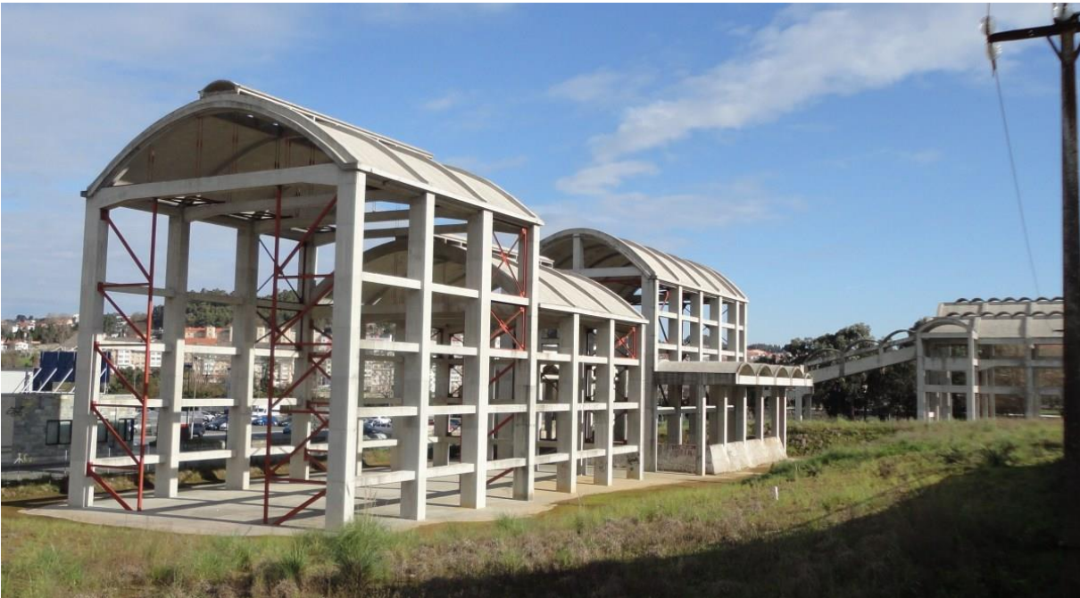
Εικόνα 4-2: Γενική εικόνα της κατασκευής μετά την επισκευή. (Diaz& Diaz Architects S.L.) [7]
