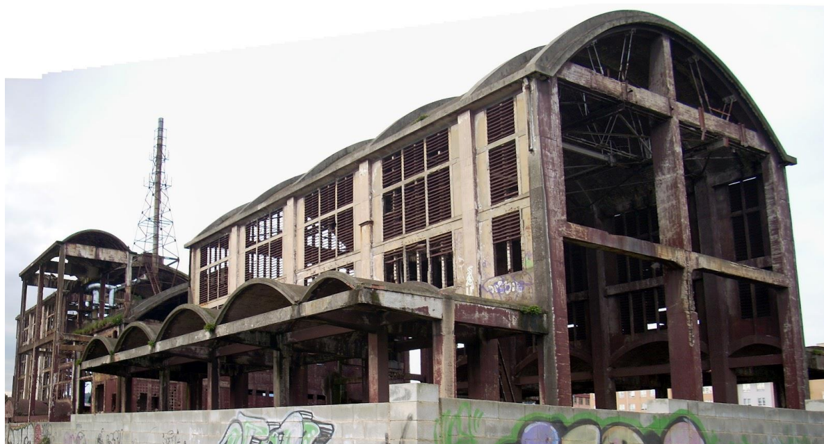
Εικόνα 4-1: Κατάσταση του βιομηχανικού κτιρίου πριν τη μετατροπή. (Diaz& Diaz Architects S.L.)
