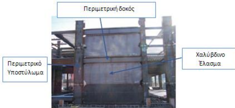
2.5- Διάταξη Χαλύβδινου Διατμητικού Τοιχώματος
