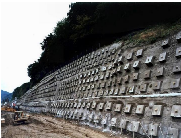
Εικόνα 5.4 “Ενδεικτική απεικόνιση αγκύρωσης πρανούς” (Sinorock, 2015)
