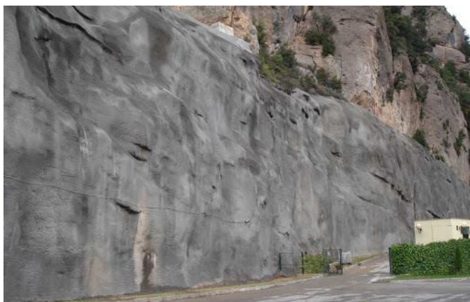
Εικόνα 5.6 “Ενδεικτική απεικόνιση εφαρμογής εκτοξευόμενου σκυροδέματος σε απότομο βραχώδες πρανές” (INACCÉS, 2007).
