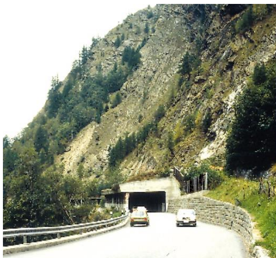
Εικόνα 5.8 “Απεικόνιση σκέπαστρου σε οδικό δίκτυο”. (Λέκκας, 2000)
