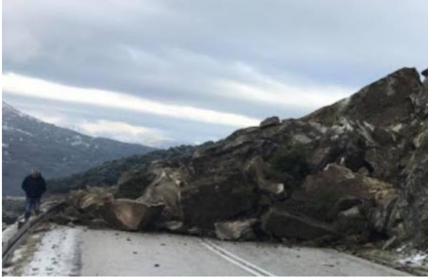
Εικόνα 7.13 " Κατολίσθηση στη παλαιά εθνική οδό Ιωαννίνων - Μετσόβου" (Αυτοδιοίκηση, 2018)
