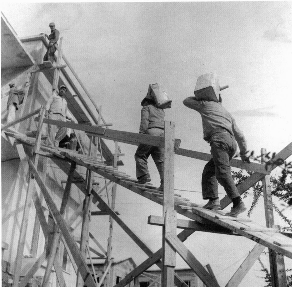
Εικόνα 20: Το ριζιμο του μπετόν με τον τενεκέ.
