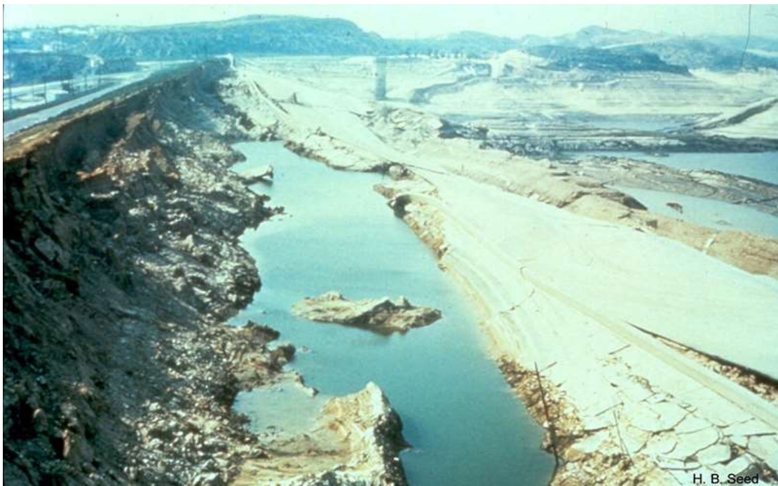
Εικόνα 4.18 Αστοχία ανάντη πρανούς του φράγματος San Fernando, με άδειο ταμιευτήρα
