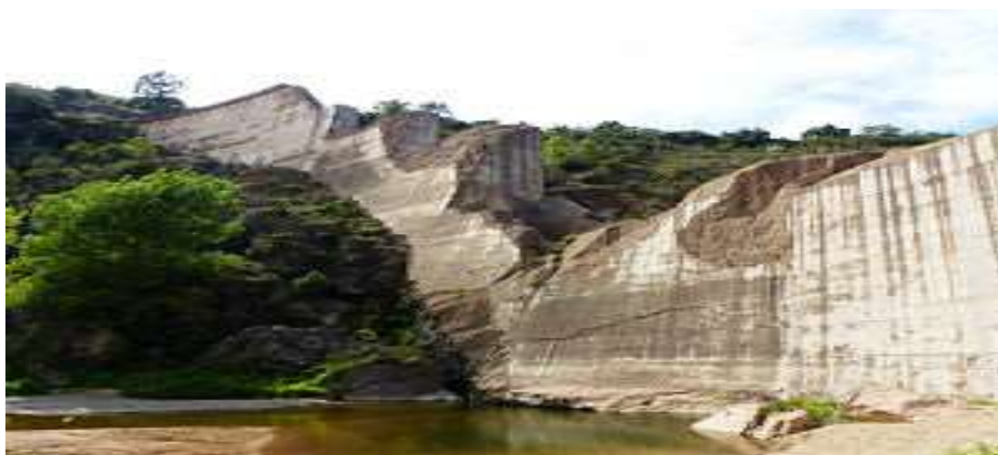
Εικόνα 2.9 φράγμα Malpasset μετά την αστοχία
