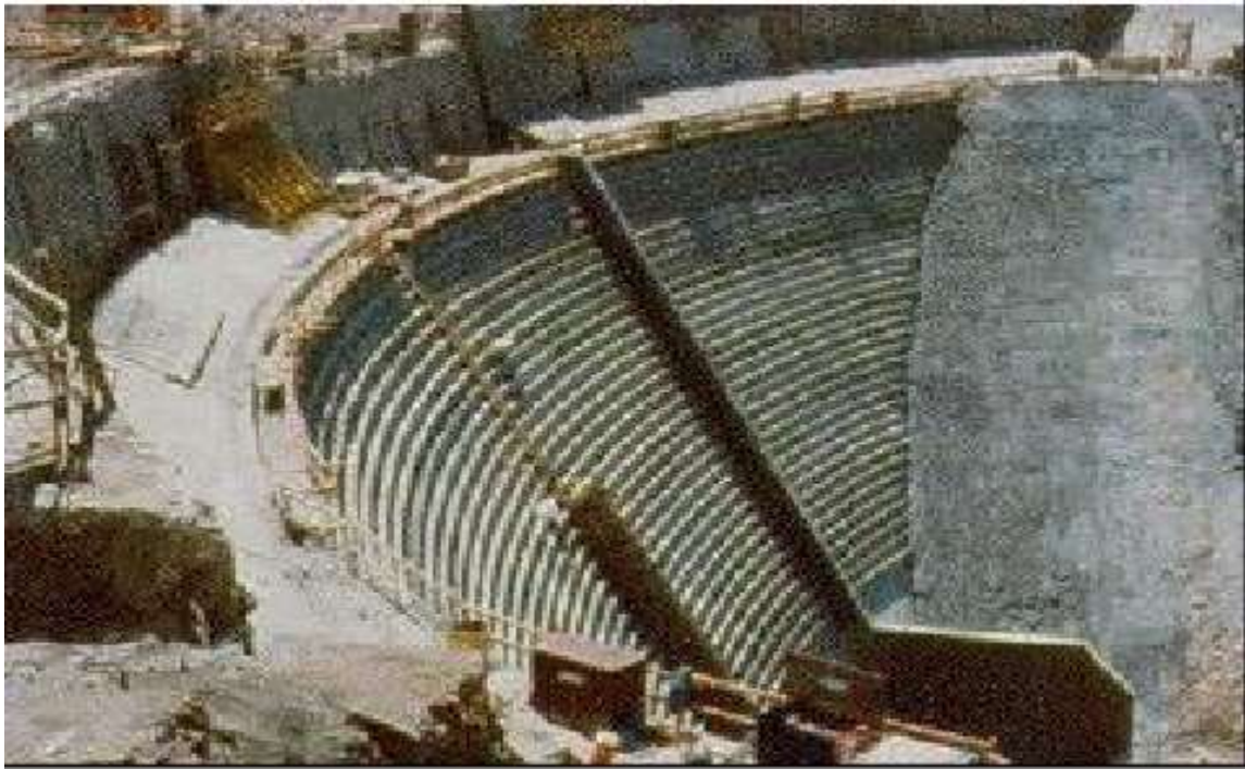
Εικόνα 3.13 Κατάντη πρόσωπο φράγματος Σάντα Κρούζ κατά την διάρκεια της κατασκευής
