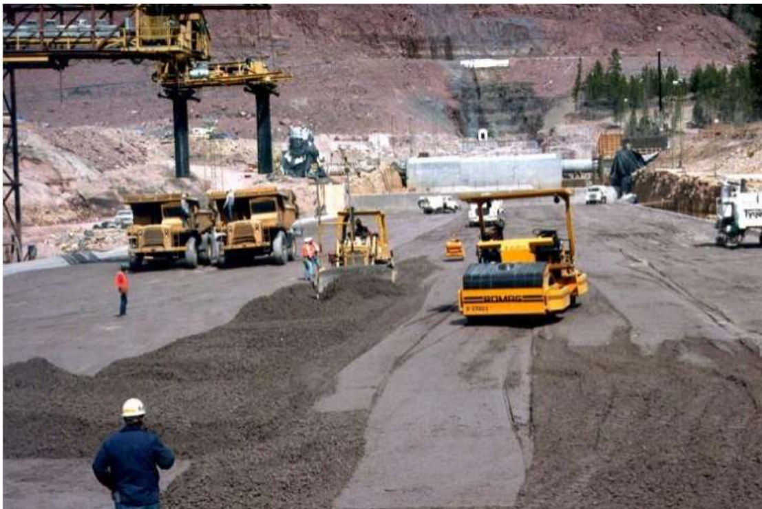
Εικόνα 3.10 Τοποθέτηση του RCC, σύστημα εξάπλωσης, συμπίκνωσης και διανομής
