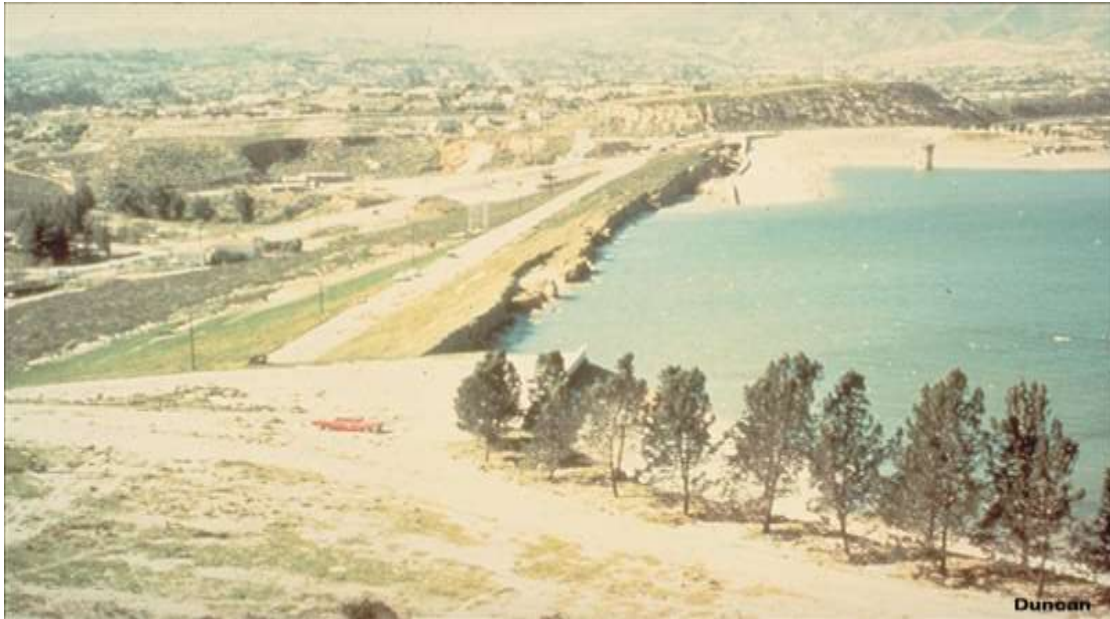
Εικόνα 4.17 Γενική όψη του φράγματος San Fernando, στην οποία φαίνεται η ολίσθηση στο ανάντη πρανές
