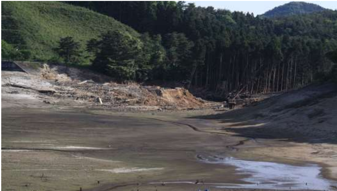
Εικόνα 4.11 Κενός ταμιευτήρας του φράγματος ύστερα από την κατάρρευση
