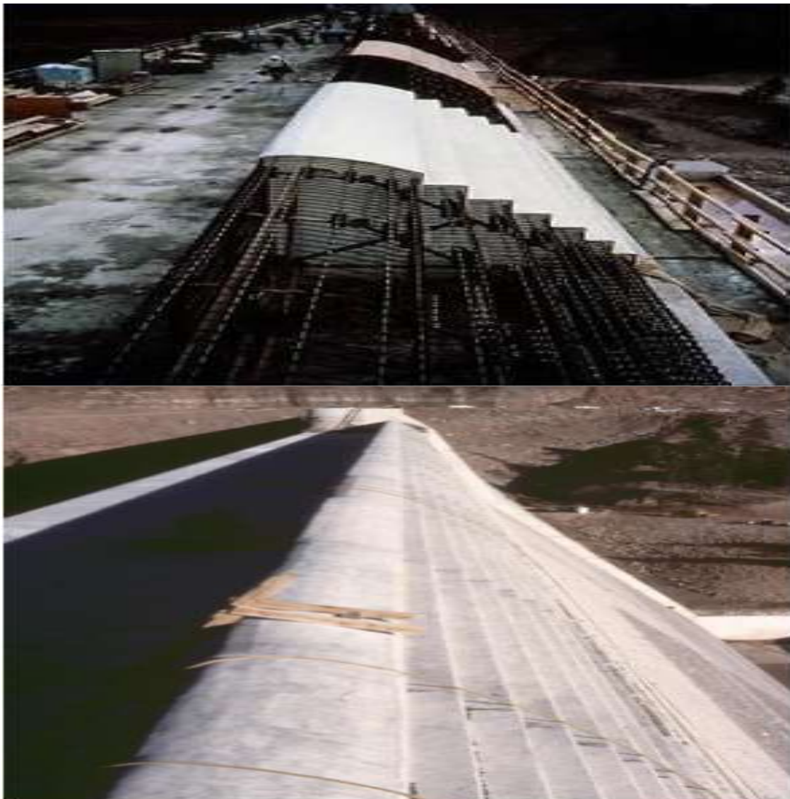
Εικόνα 3.11 Φωτογραφίες που δείχνουν τον υπό κατασκευή υπερχειλιστή
