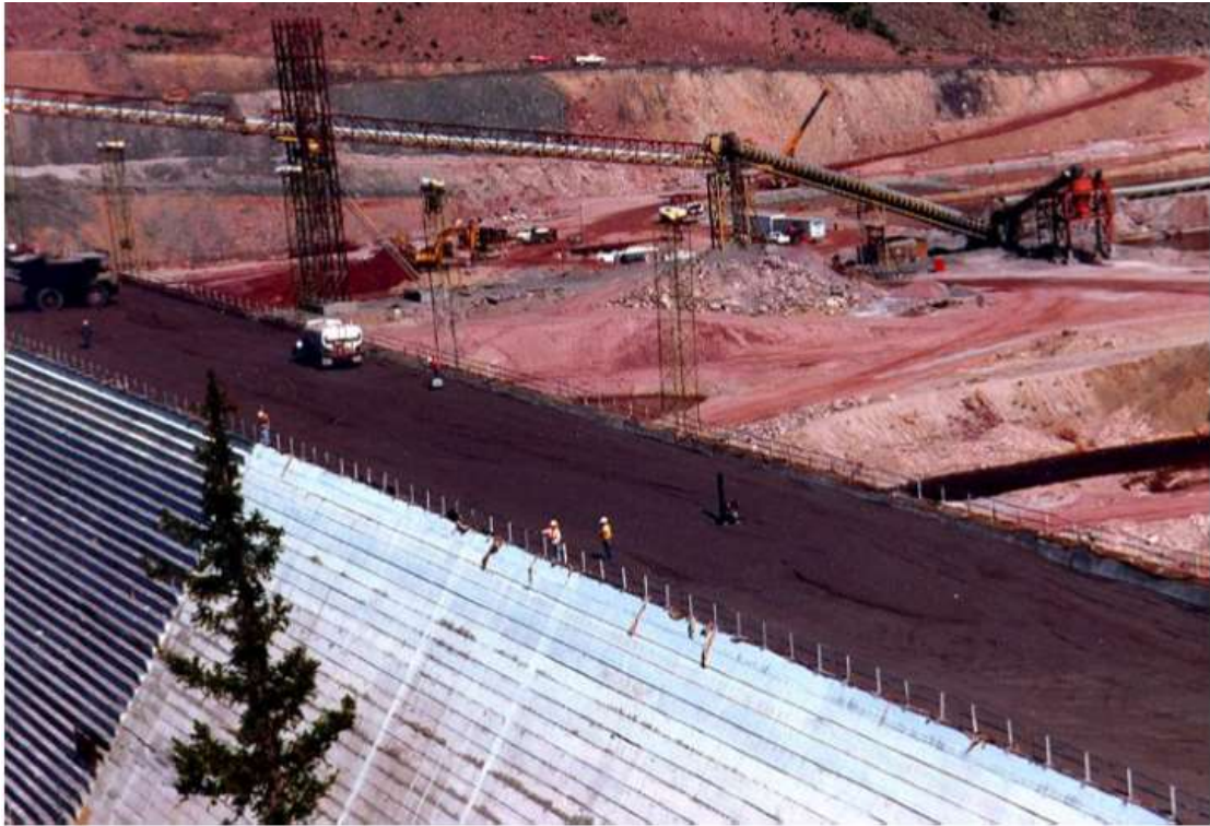
Εικόνα 3.9 Φωτογραφία κατάντη σώματος του φράγματος κατά την διάρκεια της κατασκευής
