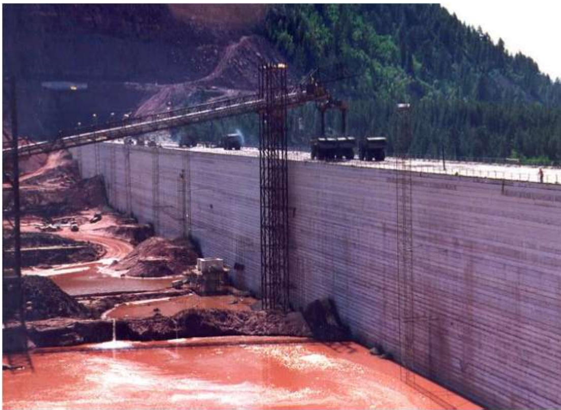
Εικόνα 3.8 Φωτογραφία του ανάντη προσώπου του φράγματος κατά την διάρκεια της κατασκευής
