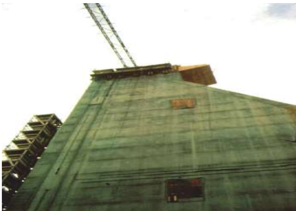
Εικόνα 3.1 Φράγμα Forebay: διαμόρφωση μονολίθων
