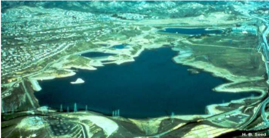
Εικόνα 4.15 Πανοραμική όψη του φράγματος San Fernando, το οποίο βρίσκεται στην αριστερή γωνία της εικόνας
