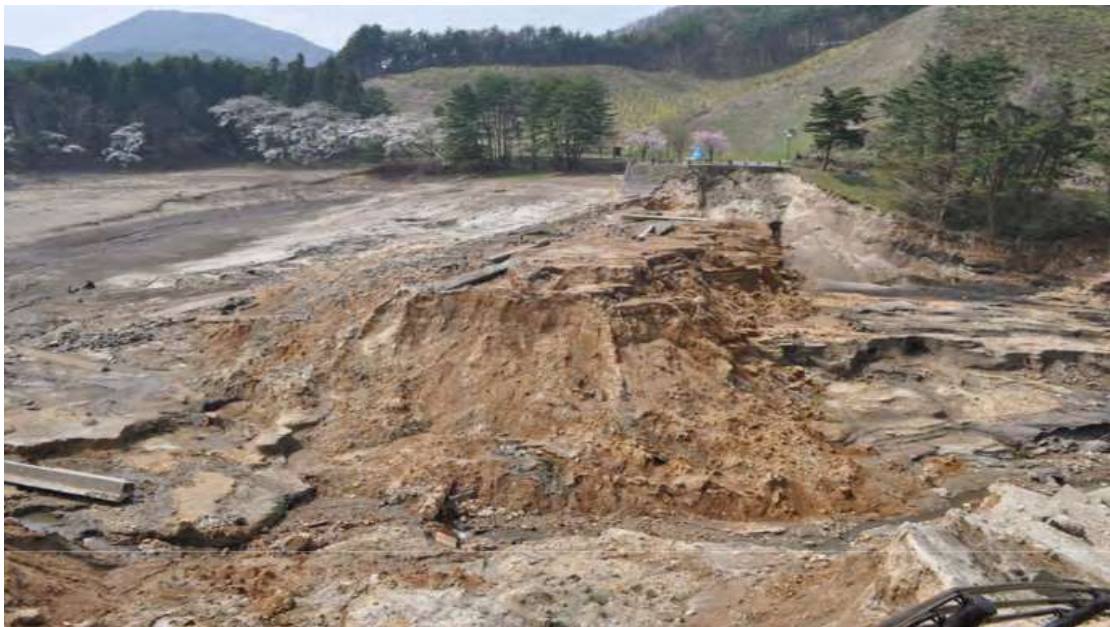
Εικόνα 4.12 Αστοχία που προκλήθηκε στον ταμιευτήρα του φράγματος
