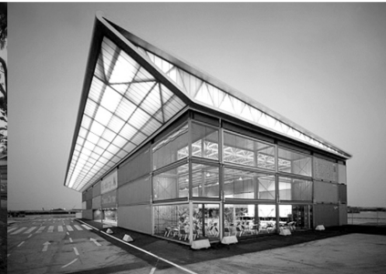
HH Cruise Center Renner Heinke Wirth Architekten, 2002
