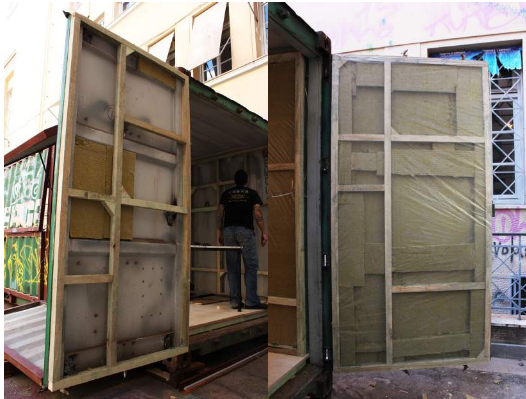
Αριστερά: Κόψιμο του πετροβάμβακα πάχους 40 mm & βενζινοκόλλα Δεξιά: Τοποθέτηση πετροβάμβακα πίσω από τον ξύλινο σκελετό σε πόρτες και πίσω τοίχο, ενώ ανάμεσα στα καδρόνια στο σκελετό ταβανιού λόγω περιορισμένου χώρου και ευκολίας
