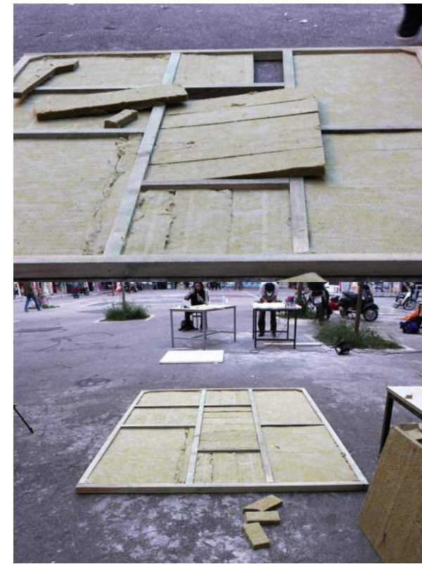
Αριστερά: Κόψιμο του πετροβάμβακα πάχους 40 mm & βενζινοκόλλα Δεξιά: Τοποθέτηση πετροβάμβακα πίσω από τον ξύλινο σκελετό σε πόρτες και πίσω τοίχο, ενώ ανάμεσα στα καδρόνια στο σκελετό ταβανιού λόγω περιορισμένου χώρου και ευκολίας
