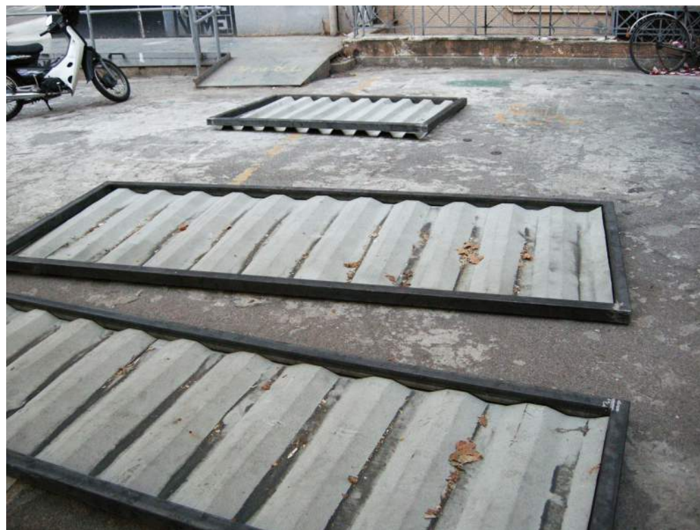
Τοποθέτηση & κόλληση της κομμένης στραντζαριστής λαμαρίνας του container σε πλαίσια-κουφώματα από ενισχυμένες κοιλοδοκούς 60x60mm
