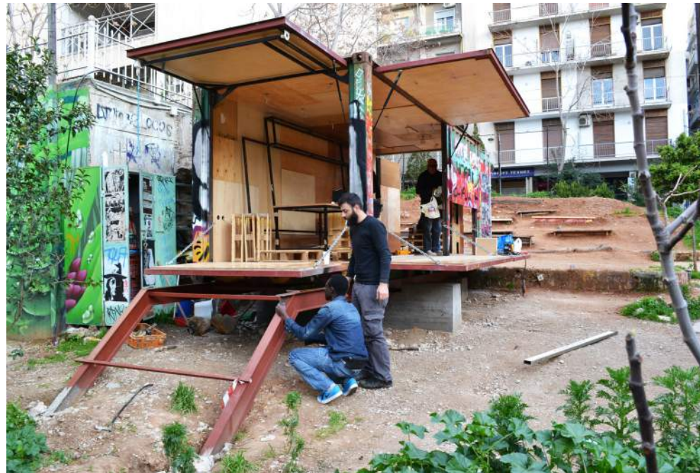
Το container στο Πάρκο [φτιάχνοντας τη σκάλα]
