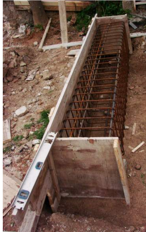
Κατασκευή καλουπιού & τοποθέτηση μανδύα από μπετόβεργες μέσα στη ξύλινη κατασκευή
