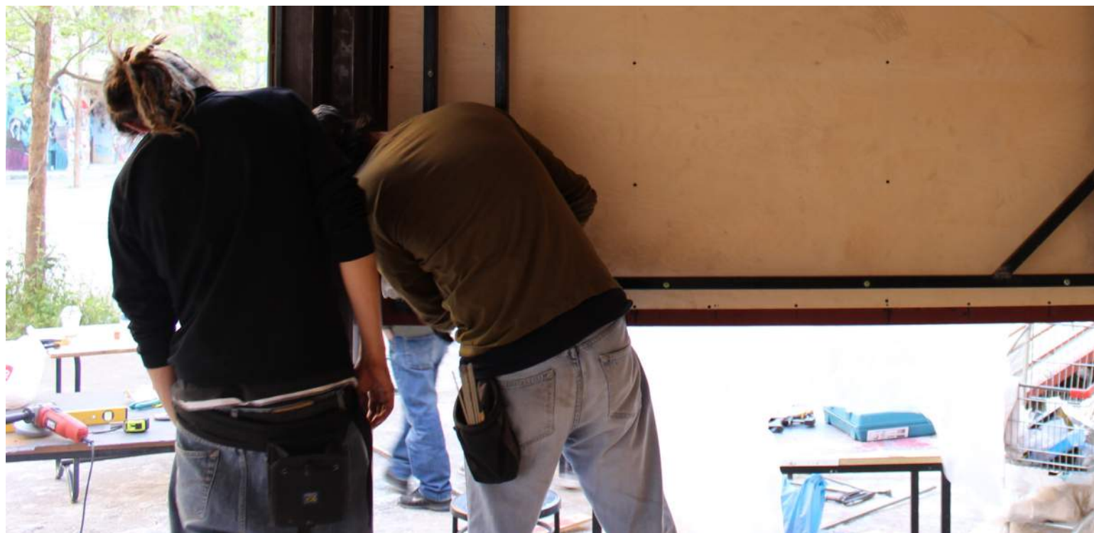
Σκελετός αναδιπλούμενου στέγαστρου με τριγωνισμούς [πλήρωση καλαμωτής] που αποτελείται από επαναχρησιμοποιημένες στραντζαριστές διατομές 30x30mm
