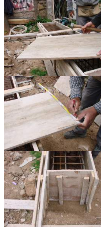
Κατασκευή καλουπιού & τοποθέτηση μανδύα από μπετόβεργες μέσα στη ξύλινη κατασκευή
