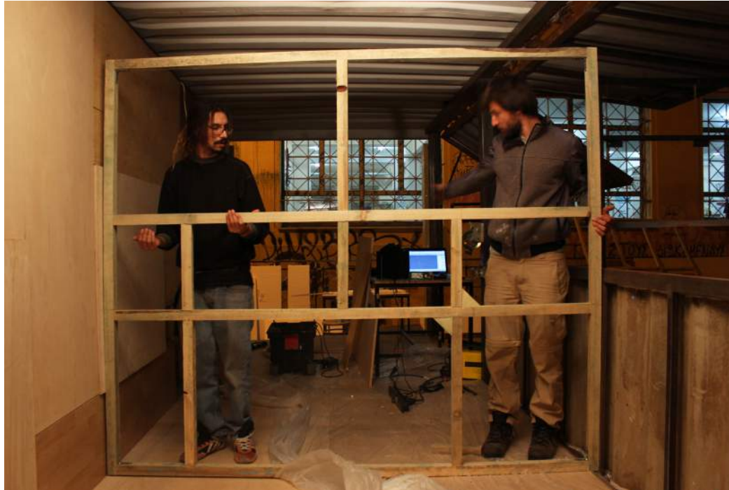
Ο σκελετός επένδυσης της οροφής προκατασκευάστηκε και χωρίστηκε σε 3 μέρη για λόγους ευκολίας στην τοποθέτηση
