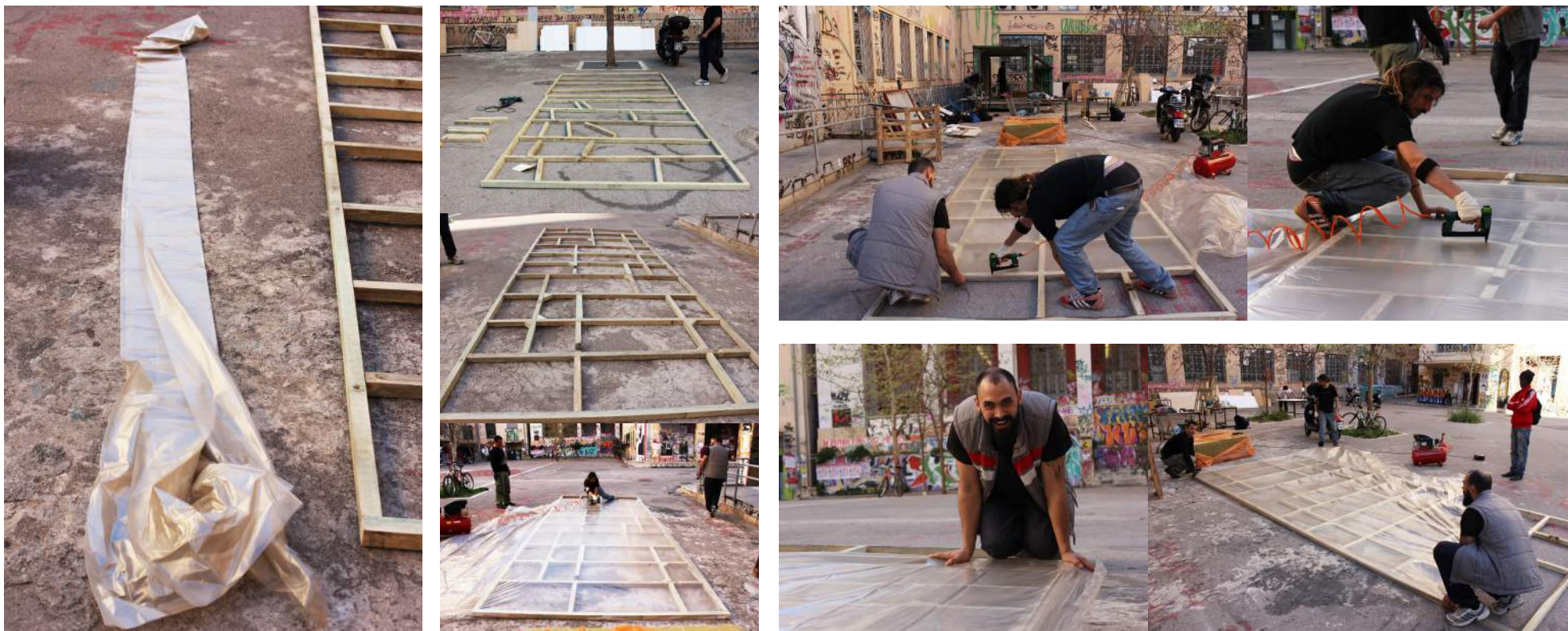
Κατασκευή ξύλινου σκελετού πίσω τοίχου & επικάλυψη με νάυλον για την απομόνωση του εσωτερικού χώρου από τον ανθυγιεινό πετροβάμβακα [καδρόνια 45x45mm]
