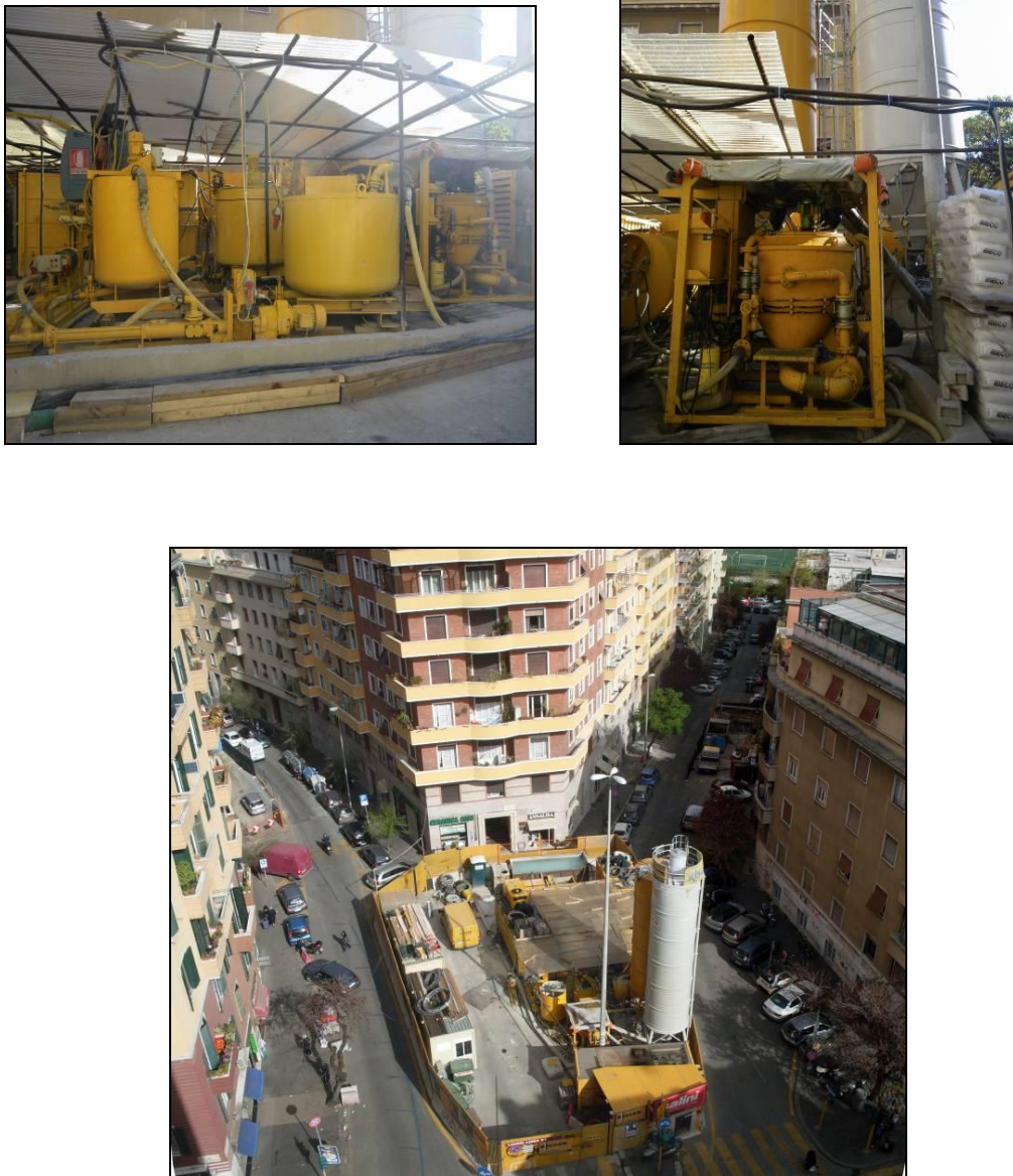
Σχήμα 2.10 Μονάδα παραγωγής ενέματος στην πλατεία Bologna της Ρώμης, στα πλαίσια επέκτασης του Μετρό
