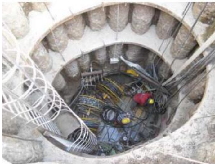
Σχήμα 5.8 Άποψη του φρέατος για την εγκατάσταση σωλήνων για τη δοκιμαστική ενεμάτωση σε φυσική κλίμακα (C. Kummerer et al, 2011)
