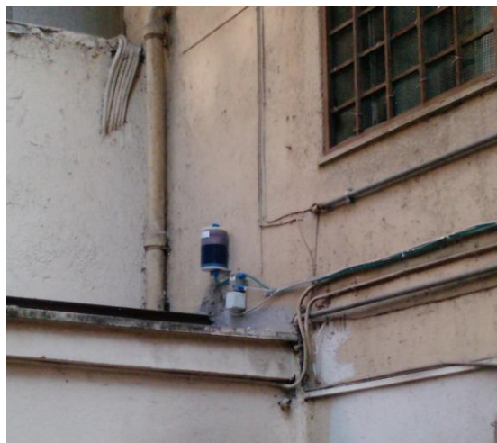
Σχήμα 2.23 Θέσεις τοποθέτησης κυλινδρικών δοχείων με νερό για τη μέτρηση της παραμόρφωσης κτιρίων κατά την εφαρμογή της μεθόδου αντισταθμιστικών τιμεντενέσεων στα πλαίσια κατασκευής νέας γραμμής Μετρό στη Ρώμη
