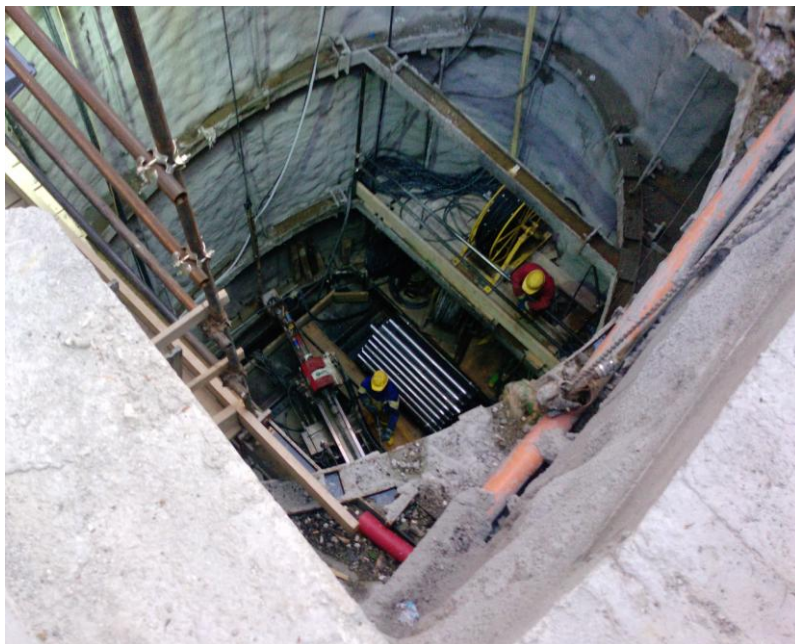
Σχήμα 2.8 Φρέατα εγκατάστασης σωλήνων ενεμάτωσης στα πλαίσια εκτέλεσης αντισταθμιστικών τσιμεντενέσεων κατά την επέκταση του Μετρό της Ρώμης
