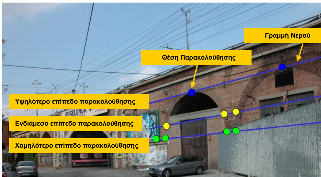
Σχήμα 2.25 Εγκατεστημένο υδραυλικό σύστημα για την παρακολούθηση των μετακινήσεων μιας ιστορικής σιδηροδρομικής γέφυρας κατά την επέκταση της γραμμής Μετρό στη Ρώμη
