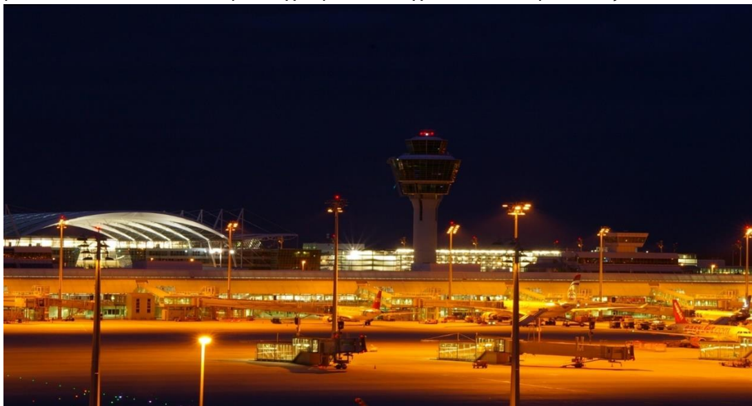
Εικόνα 45 Λαμπτήρες σηματοδότησης αεροδρομίου.
