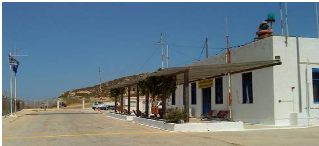
Εικόνα 40 Κτίριο επιβατών αεροδρομίου Καστελόριζου
