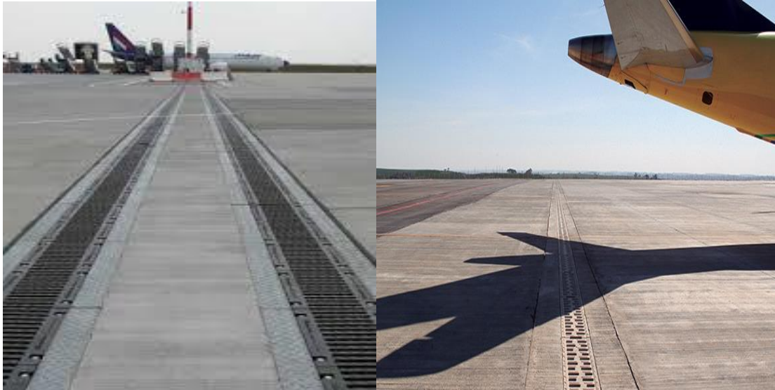
Εικόνα 37 Συστήματα Αποστράγγισης Αεροδρομίων Τμήμα Α
