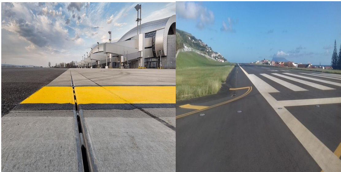
Εικόνα 38 Συστήματα Αποστράγγισης Αεροδρομίων Τμήμα Β
