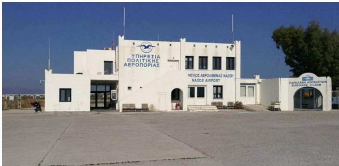
Εικόνα 39 Κτίριο επιβατών αεροδρομίου Νάξου
