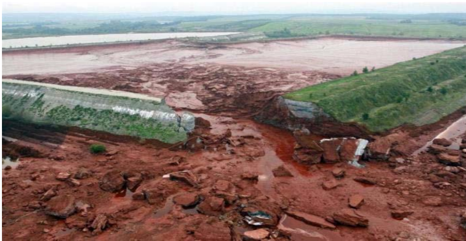
Εικόνα 5 Καταστροφή δεξαμενής απόρριψης καταλοίπων βωξίτη στην Ουγγαρία το 2010
