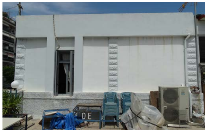
Σχήμα 2.19: Δυτική όψη του χώρου των γραφείων.
