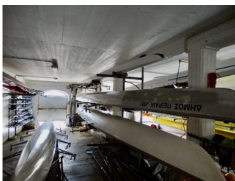
Σχήμα 4.42: Απουσία βλαβών στην οροφή της δυτικής πτέρυγας.
