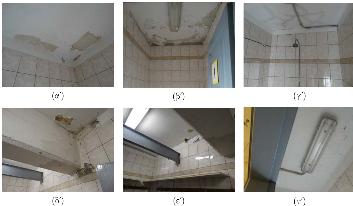
Σχήμα 4.40: (α'), (β'), (γ') Ρωγμές και φθορές στον χώρο αποδυτηρίων και ντους των γυναικών. (δ'), (ε'), (ς') Ρωγμές και φθορές στον χώρο αποδυτηρίων και ντους των ανδρών.
