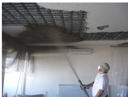
Σχήμα 7.2: Εφαρμογή εκτοξευόμενου σκυροδέματος σε πλάκα.
