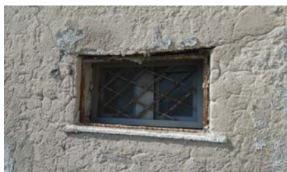
Σχήμα 4.15: Παραμόρφωση ανωφλίου.
