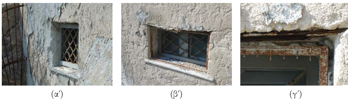
Σχήμα 4.18: (α'), (β') , (γ') Οξείδωση μεταλλικών στοιχείων.
