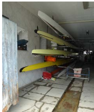
Σχήμα 4.33: Απουσία φθορών και βλαβών στην εσωτερική όψη του δυτικού τοίχου του ισογείου.
