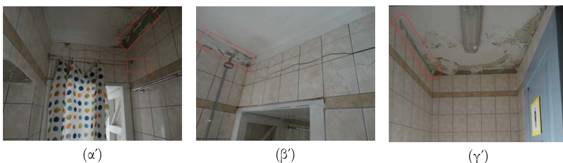
Σχήμα 4.29: (α'), (β'), (γ') Βλάβες και φθορές στο βορεινό τοίχο των γυναικείων λουτρών.
