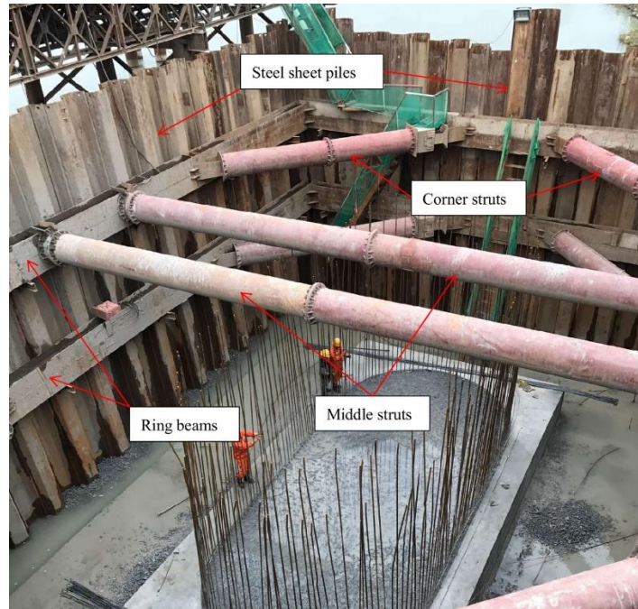
Εικόνα 1.20 Κατασκευή τοίχου αντιστήριξης από μεταλλικές πασσαλοσανίδες και αντρίδες.
