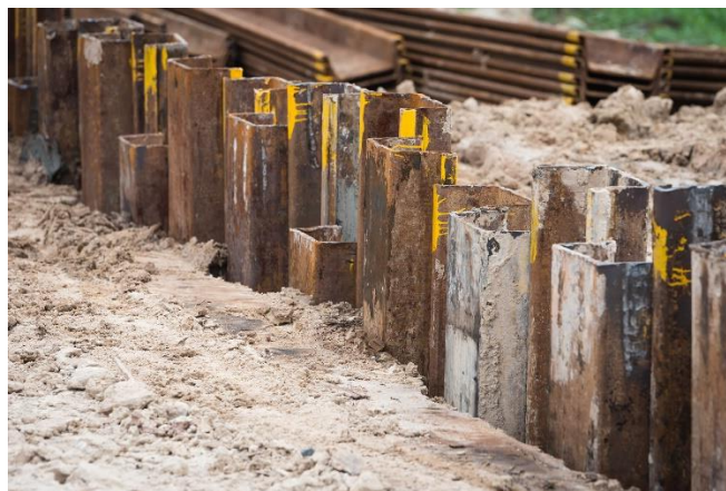
Εικόνα 1.19 Έμψη μεταλλικών πασσαλοσανίδων πριν την εκσκαφή.
