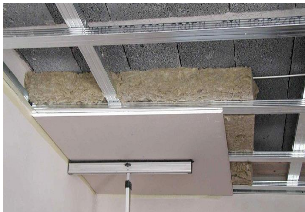
Εικόνα 1.11 Ενδεικτική εφαρμογή ψευδοροφής με εφαρμογή πετροβάμβακα.
