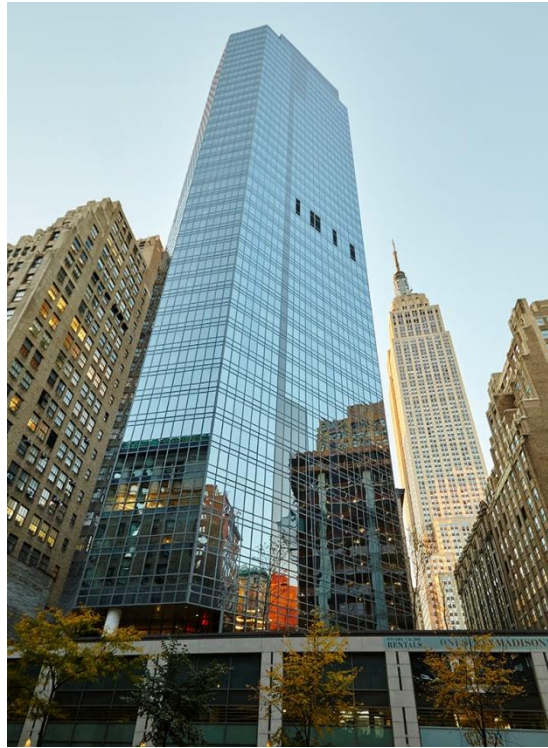
Εικόνα 1.9 Εφαρμογή συστήματος υαλοπετασμάτων SMARTIA M85s της εταιρίας ALUMIL σε κτίριο μεγάλου ύψους στην Νέα Υόρκη – ΗΠΑ.
