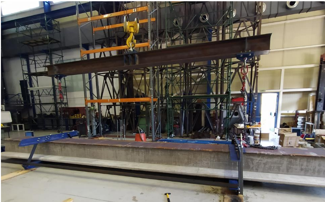
Σχήμα 2.9: Σύστημα μεταφοράς των δοκιμίων με χρήση της γερανογέφυρας.
