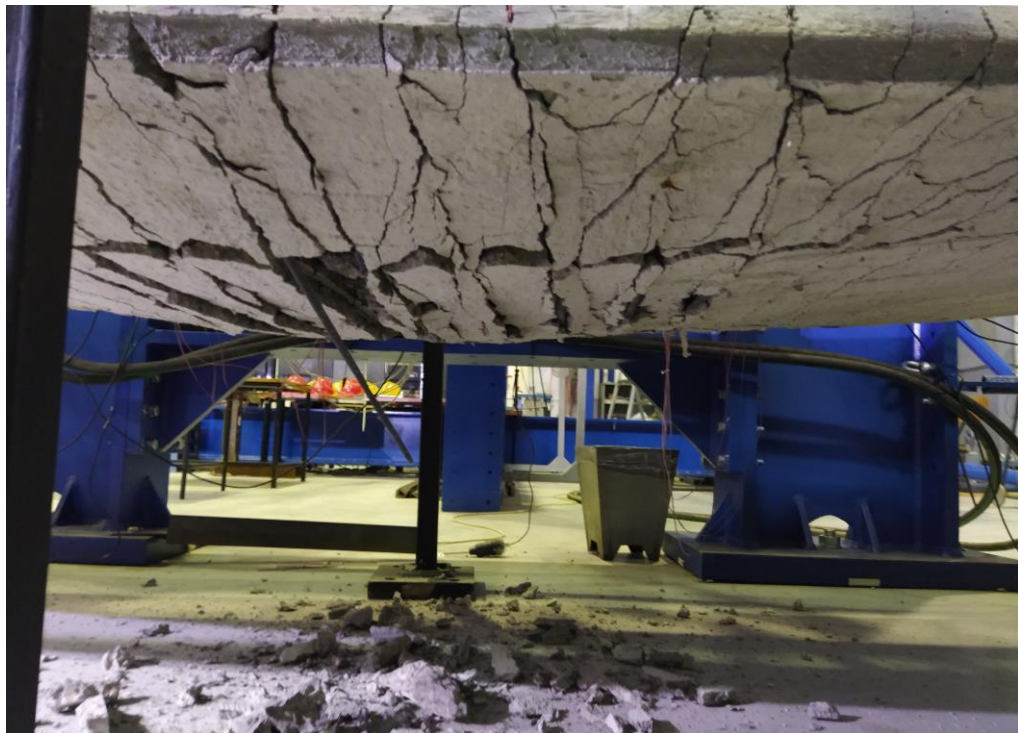
Σχήμα 4.17: Αποφλοίωση σκυροδέματος εφελκόμενης ίνας δοκιμίου Η3 και αστοχία μιας εκ των εγκάρσιων ράβδων οπλισμού.
