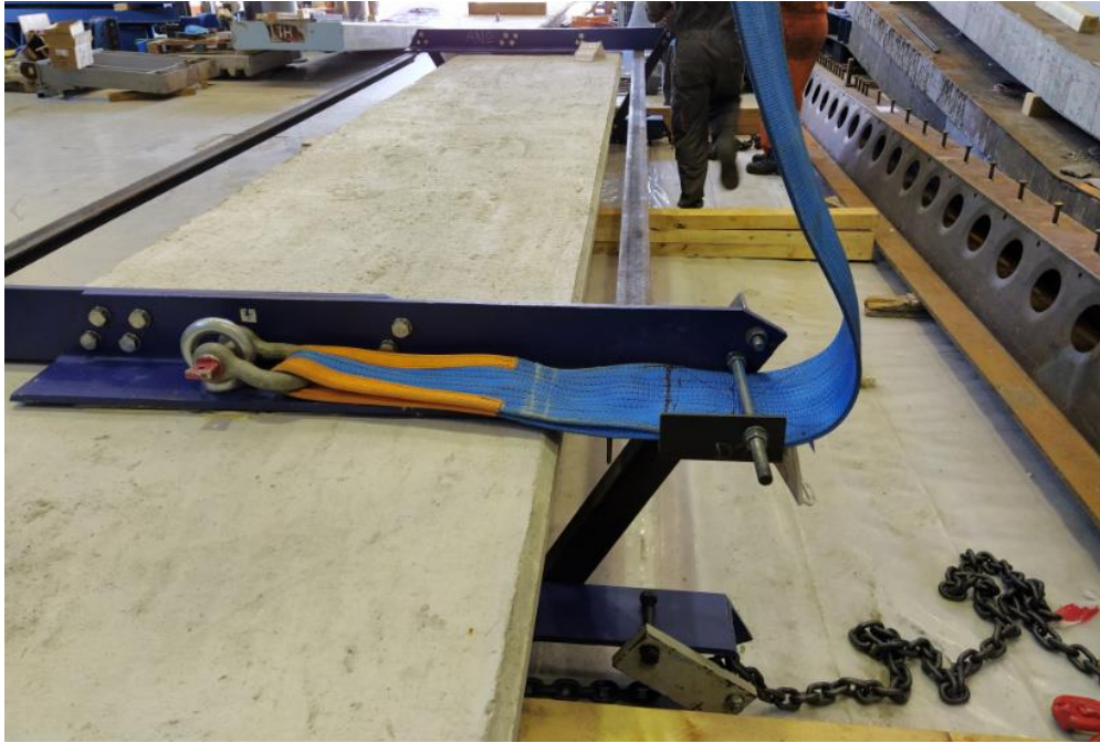
Σχήμα 2.8: Τοποθέτηση φασκιάς στην άνω σπείρα ανάρτησης.
