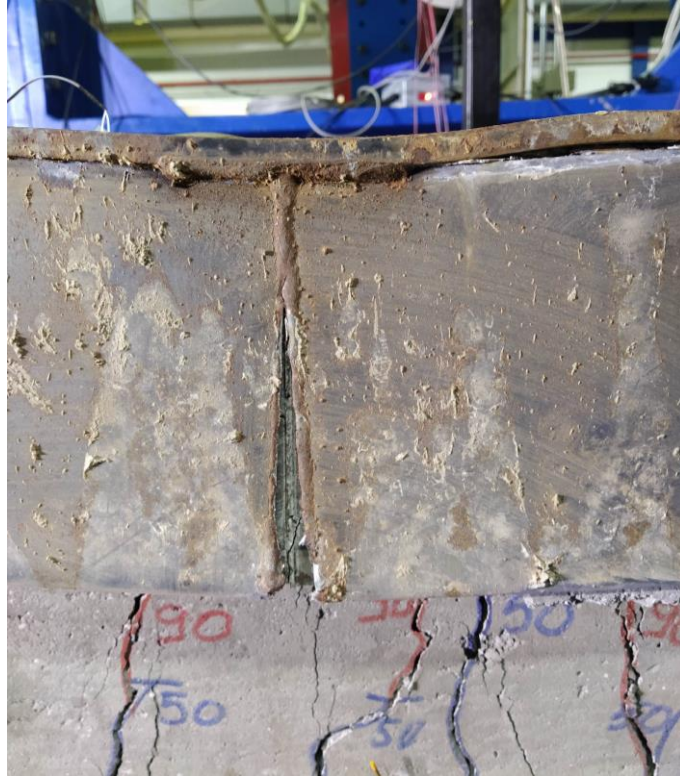
Σχήμα 4.31: Αστοχία συγκόλλησης ελασμάτων σιδηροδοκού .
