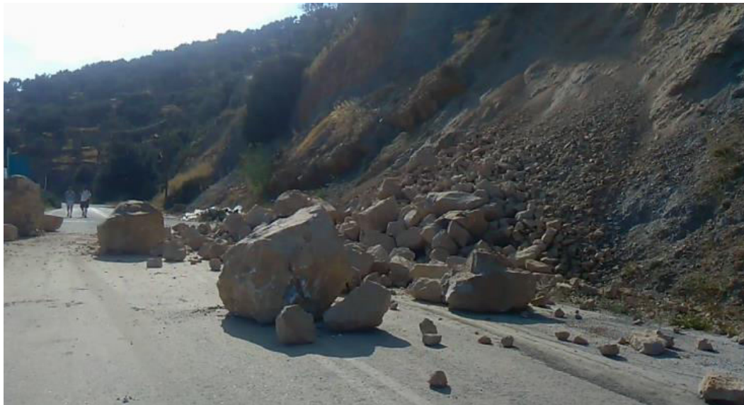
Εικόνα 2.1: Κατάπτωση βράχων στο οδικό δίκτυο Πλωμαρίου – Μελίντας, (Η Καθημερινή, https://www.kathimerini.gr , 2018)
