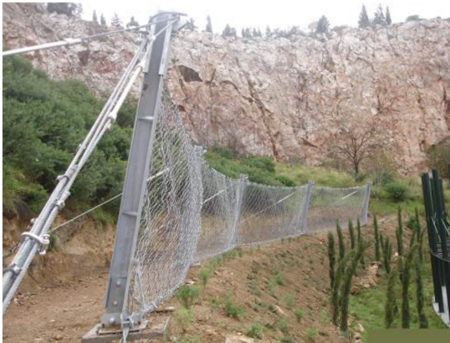
Εικόνα 2.3: Φράχτης ανάσχεσης καταπτώσεων (Maccaferri, www.maccaferri.com )
