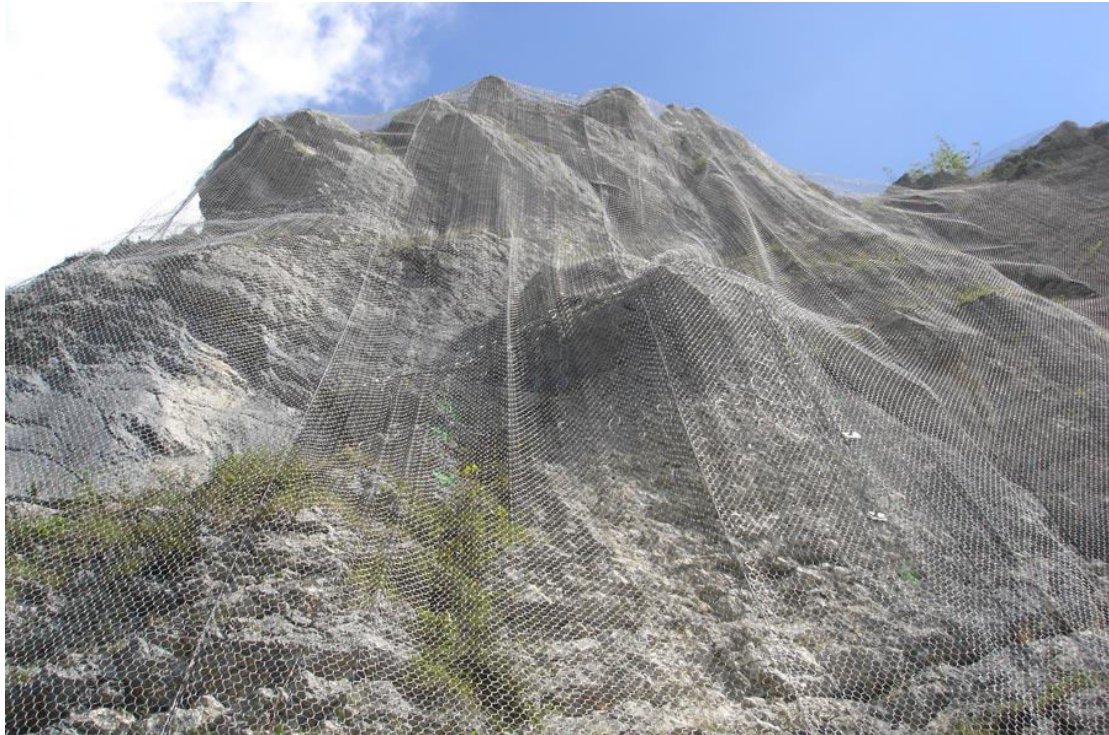
Εικόνα 2.4: Πλέγμα παγίδευσης αναρτημένο σε βραχώδες πρανές (ACRO BTP www.acrobtp.fr )
