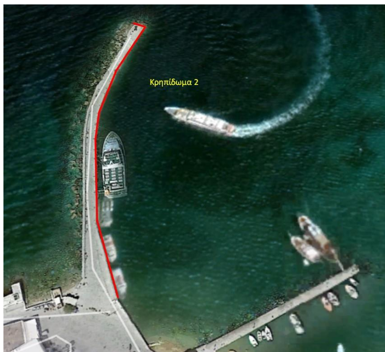
Εικόνα 8.12: «Κρηπίδωμα 2» Παλαιού Λιμένα (Πηγή: Google earth)
