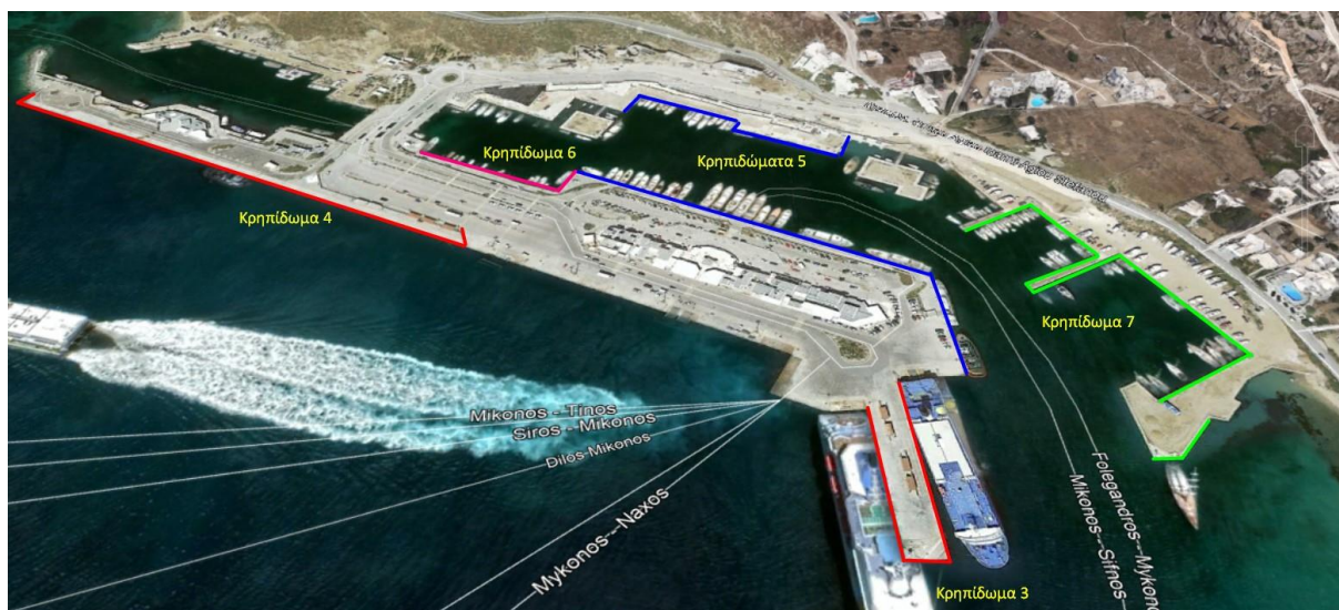
Εικόνα 8.6: Κρηπιδώματα Νέου λιμένα (Πηγή: Google earth)
