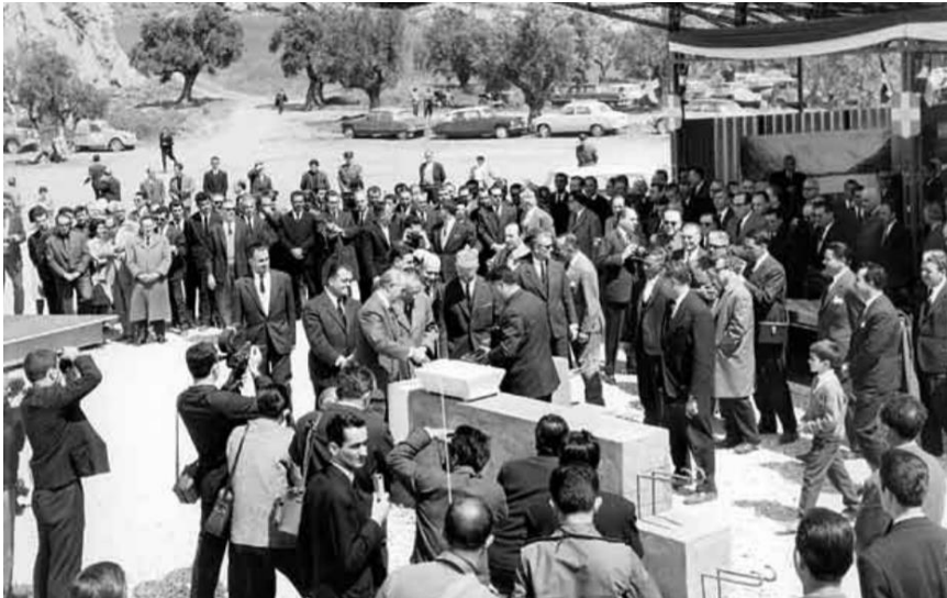
Εικόνα 43: Η τελετή θεμελίωσης του εργοστασίου https://www.alhellas.com/Uploads/entypa/ALOUMINIO_MISOS_AIONAS_GR.pdf
