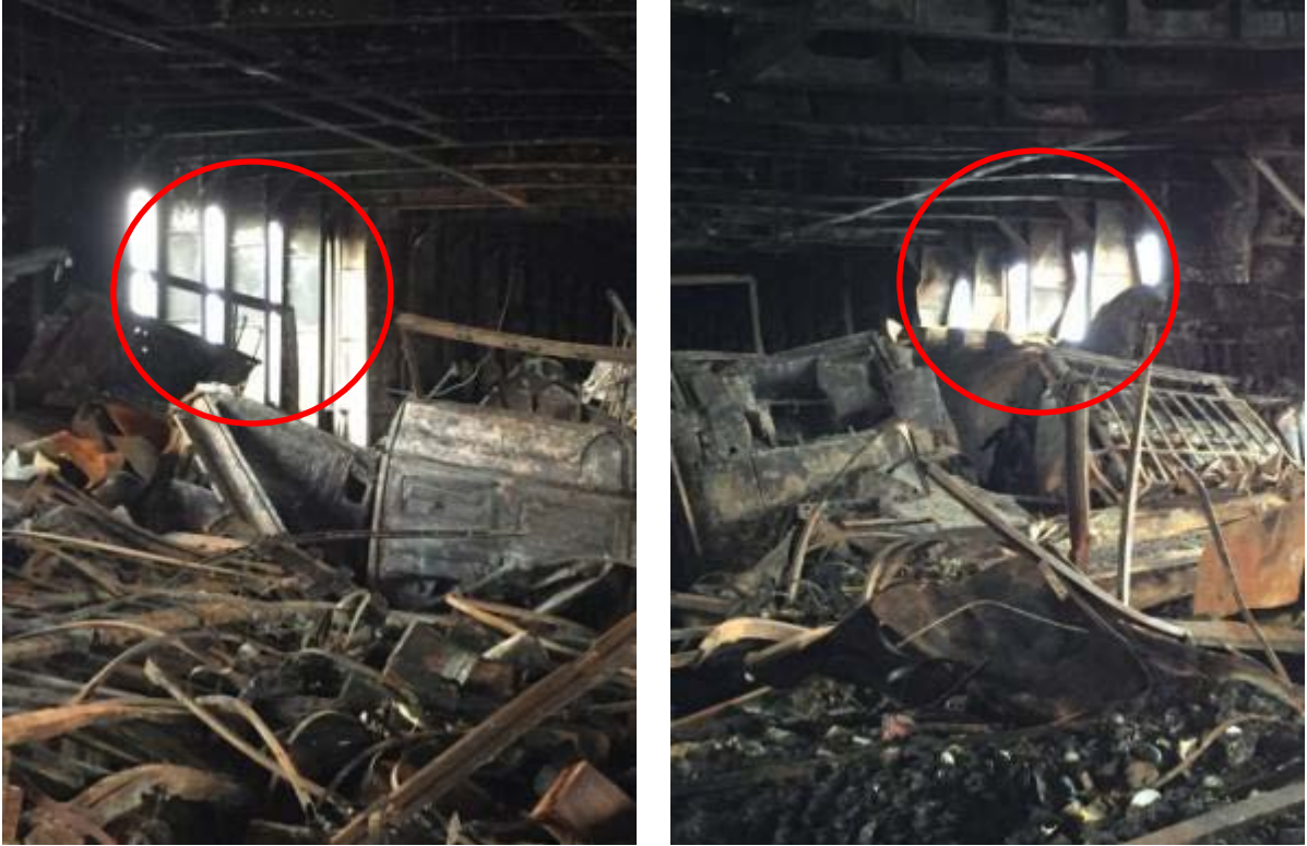
Εικόνα 9: Αριστερά = Port Side με την κατασκευή σχεδόν άθικτη, Δεξιά = Starboard Side με την κατασκευή να έχει υποστεί σημαντικές παραμορφώσεις [Ministry of Infrastructure and Transport on Norman Atlantic]
