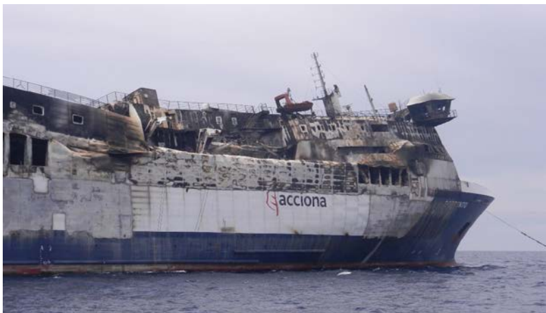
Εικόνα 14: Δεξιά πλευρά Sorrento [Ministry of Infrastructure and Transport on Sorrento]
