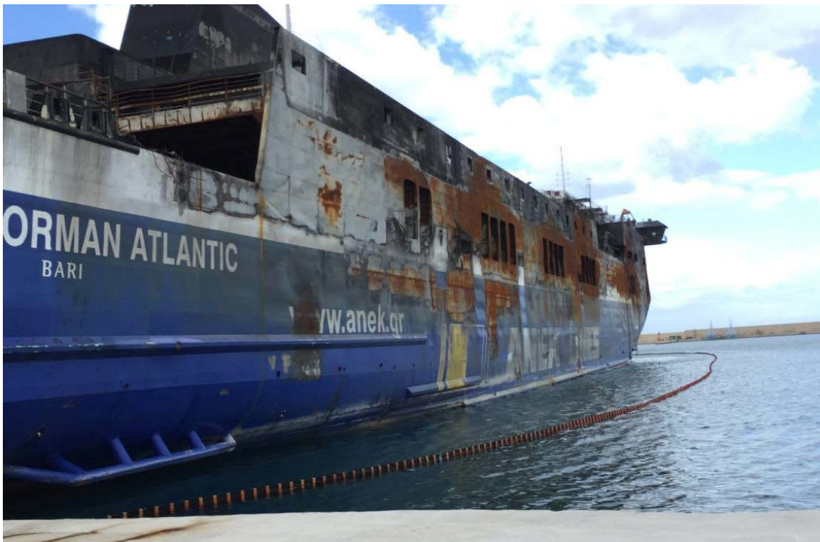
Εικόνα 8: Η δεξιά πλευρά του πλοίου που προκλήθηκαν οι περισσότερες ζημιές [Ministry of Infrastructure and Transport on Norman Atlantic]
