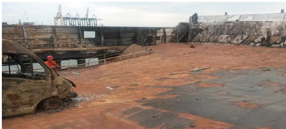
Εικόνα 16: Όψη της περιοχής που κατέρρευσε [Ministry of Infrastructure and Transport on Sorrento]
