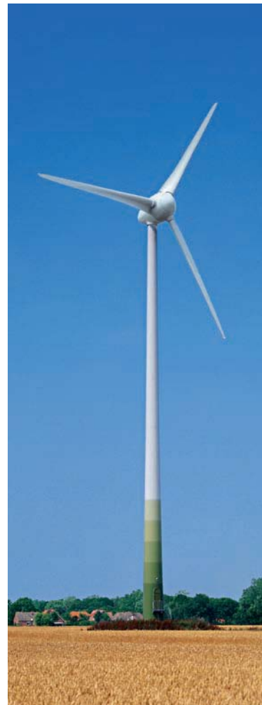
Εικόνα 5.3: Η Α/Γ Enercon E33/330 kW. (Πηγή: www.enercon.de )
