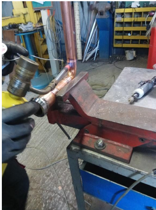
Εικ. 4.39 Διαδικασία ασιμοσυγκόλλησης ενώσεων
