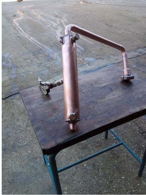
Εικ 4.42 Διαδικασία πλήρωσης με νερό και αύξηση πίεσης για εύρεση τυχών διαρροών
