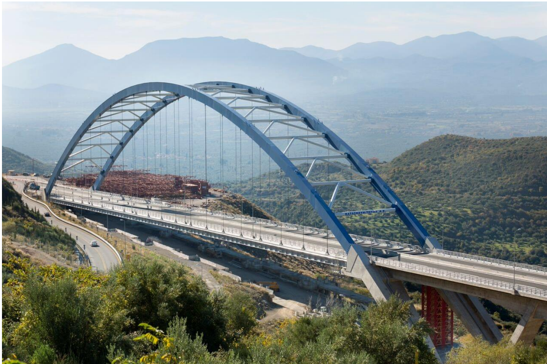
Σχήμα 3.- Τοξωτή γέφυρα (arch bridge) Τσακώνας
