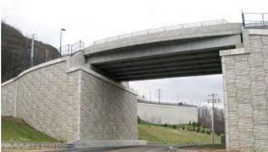
Σχήμα 8.- Γέφυρα με U - ακρόβαθρο
