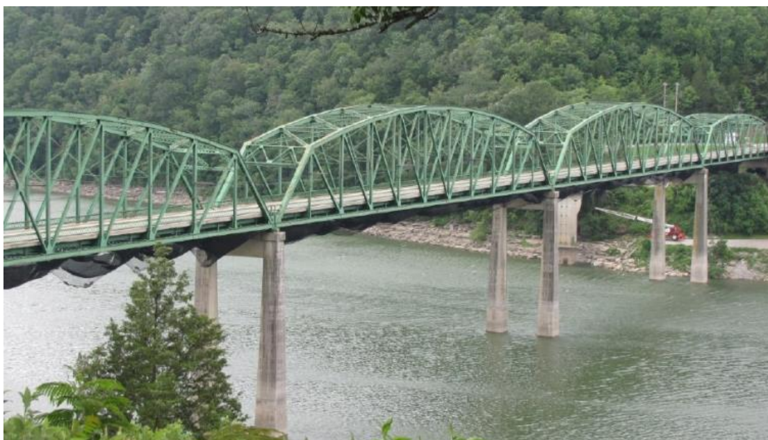
Σχήμα 2.- Γέφυρα με δικτύωμα (truss bridge)
