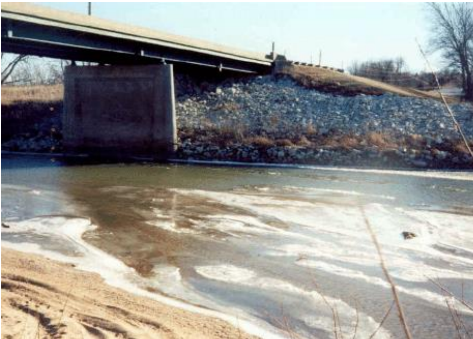
Σχήμα 9.- Γέφυρα με ακρόβαθρο ανοικτού τύπου
