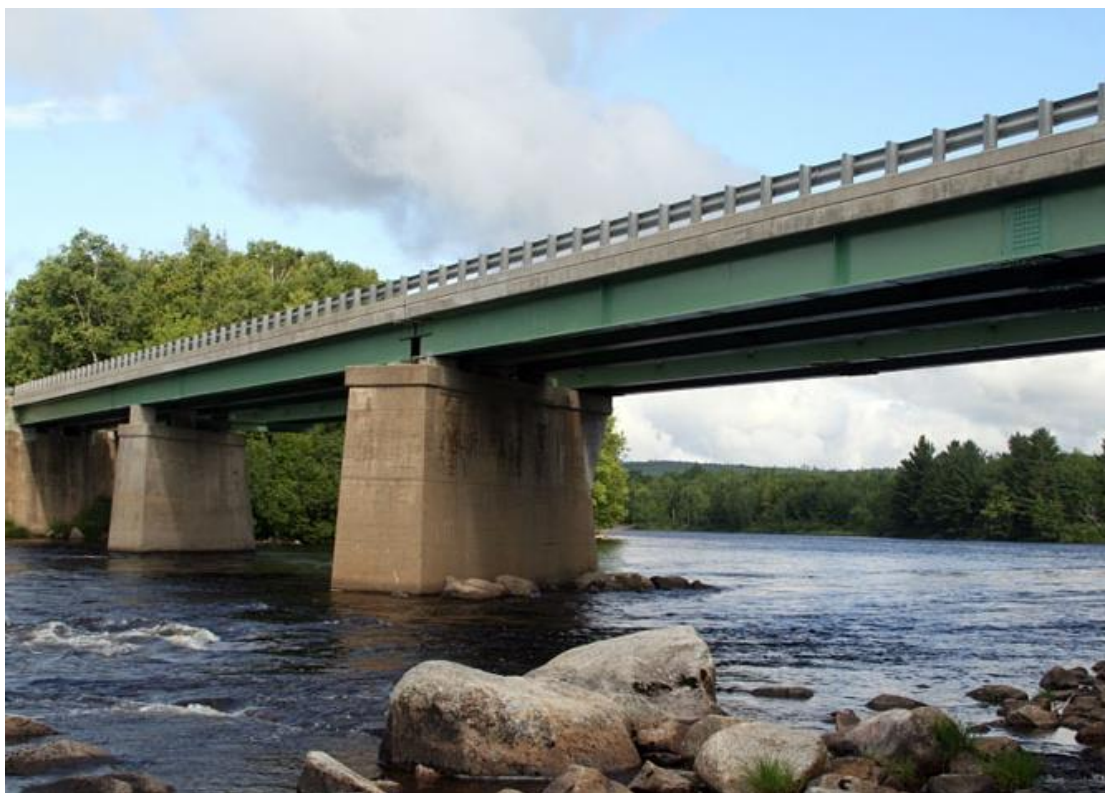
Σχήμα 1.- Γέφυρα σε δοκούς (beam bridge)
