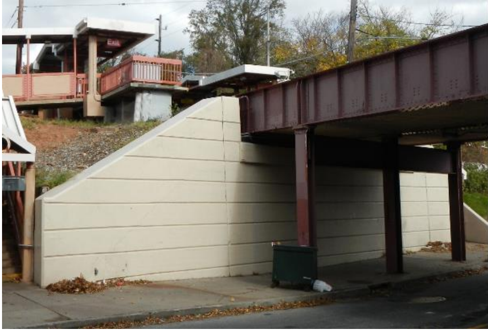
Σχήμα 7.- Γέφυρα με τυπικό ακρόβαθρο βαρύτητας
