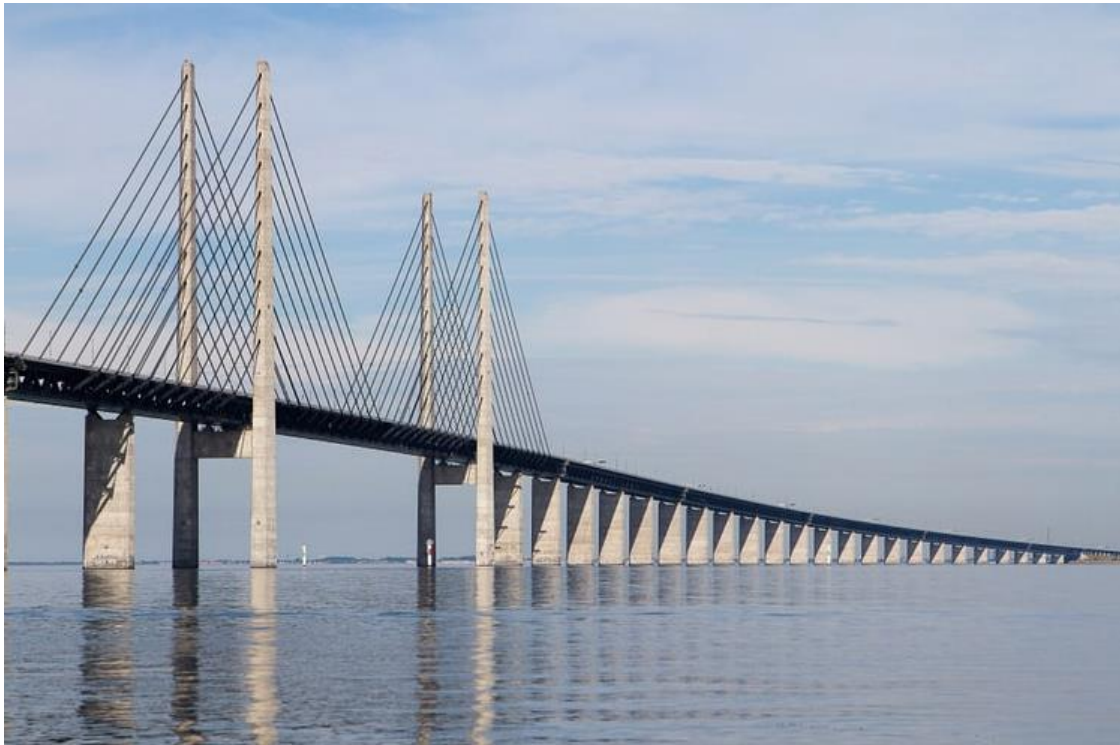
Σχήμα 4.- Καλωδιωτή γέφυρα (cable stayed bridge) Øresund
