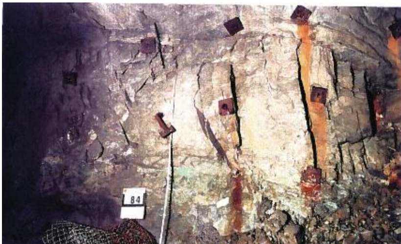
Εικόνα 3.10. Στύλος που έχει ενισχυθεί με τη βοήθεια αγκυρίων.
