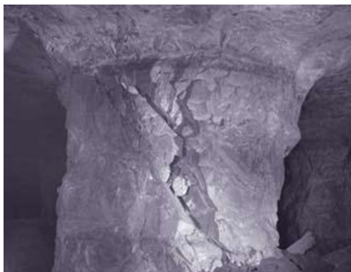
Εικόνα 1.2. Αστοχία στύλου εξαιτίας προϋπάρχουσας ασυνέχειας υπό γωνία 60^\circ .
