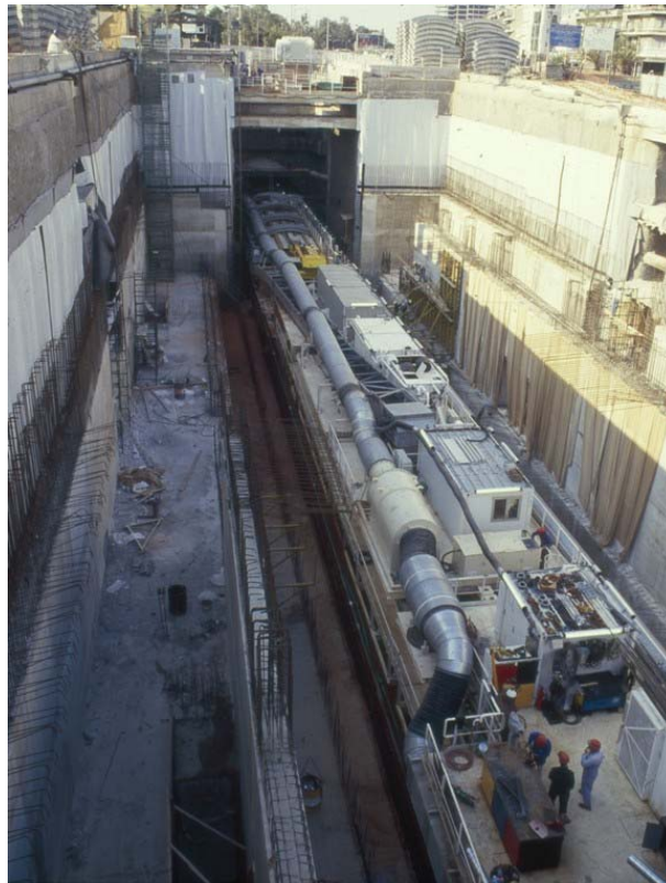
Εικ. 2-3: Άποψη των βαγονιών υποστήριξης του μηχανήματος Ανοιχτής Ασπίδας
