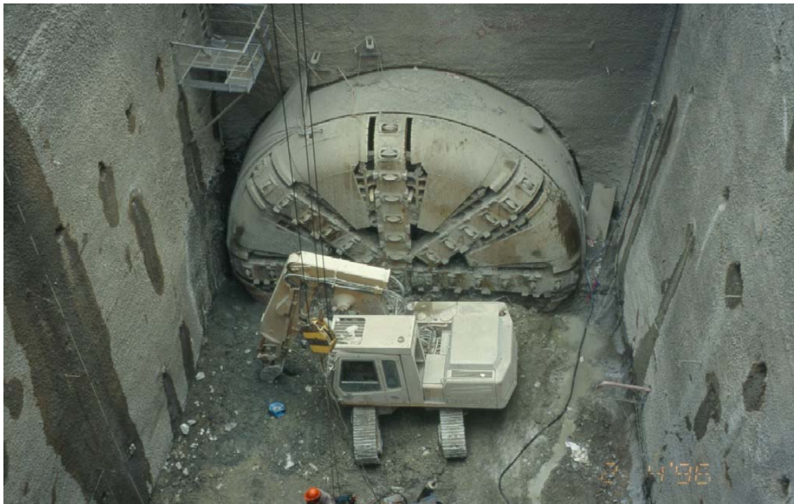
Εικ. 2-1: Μηχάνημα Διάνοιξης Σηράγγων (TBM 1 «Ιάσονας») που χρησιμοποιήθηκε για την κατασκευή της Γραμμής 2 του ΜΕΤΡΟ ΑΘΗΝΩΝ, στο τμήμα Σταθμός Λαρίσης – Σταθμός Αγ. Ιωάννη
