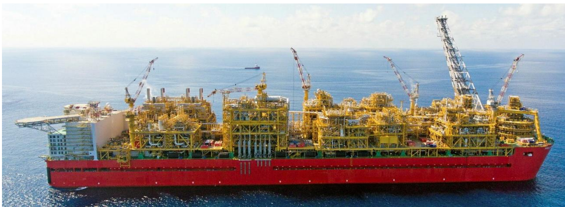
Εικόνα 2-22. Prelude της Shell. Μονάδα LNG FPSO. Πηγή: The Global Oil & Gas News Source 2020, https://www.upstreamonline.com/
