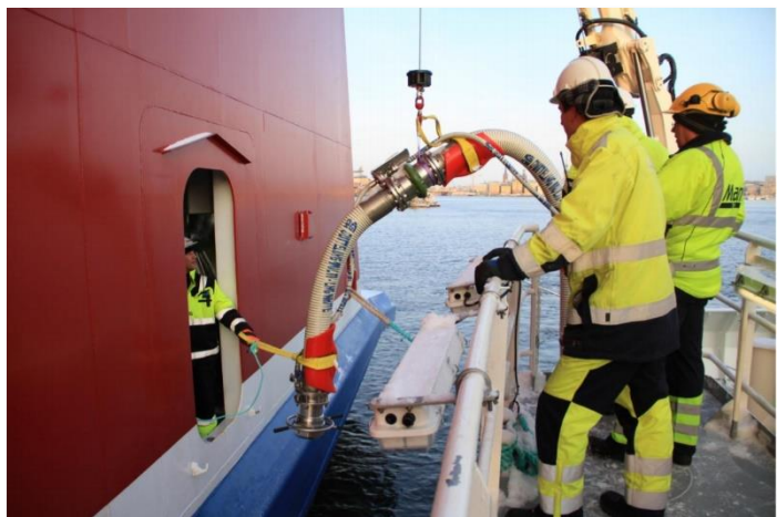
Εικόνα 2-26. Διαδικασία ανεφοδιασμού μεταξύ SEAGAS και Viking Grace. Πηγή: GTT 2016, REACH4 - LNG Bunker Mast,
