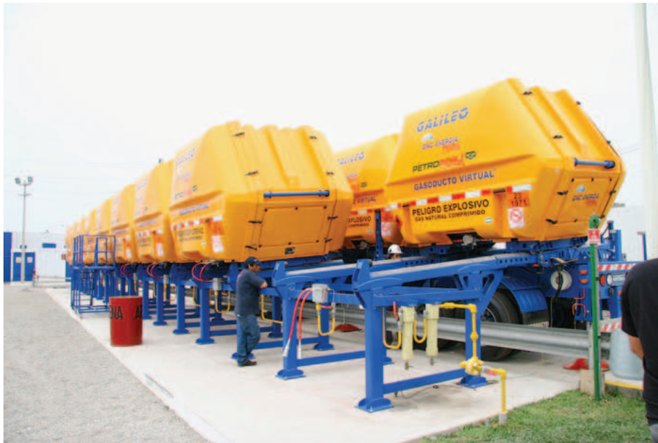
Εικόνα 3.6 Γέμισμα κινητών δεξαμενών
