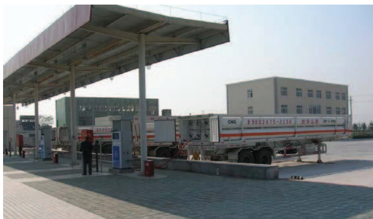
Εικόνα 4.5 Τυπικός σταθμός ανεφοδιασμού cng
