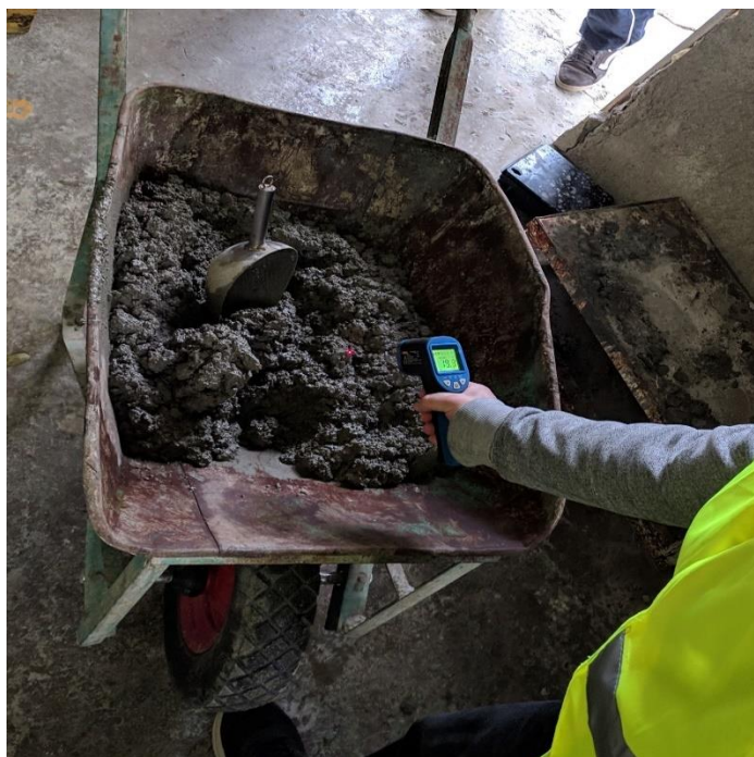
Εικόνα 6. 2 Θερμομέτρηση του νωπού σκυροδέματος πριν την παρασκευή δοκιμίων
