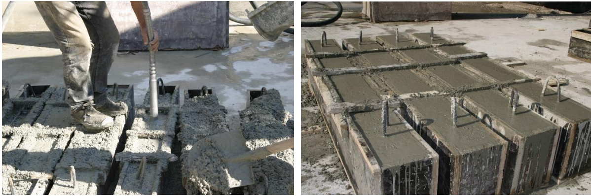
Εικόνα 5. 3 Σκυροδέτηση (με δόνηση) δοκών οπλισμένου σκυροδέματος
