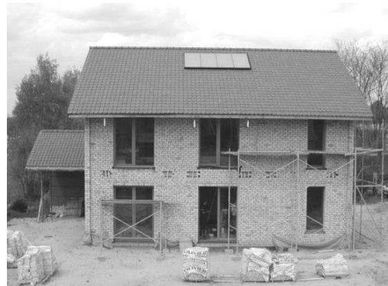
Εικόνα 3.2: Νότια όψη του υπό μελέτη κτιρίου (70)
