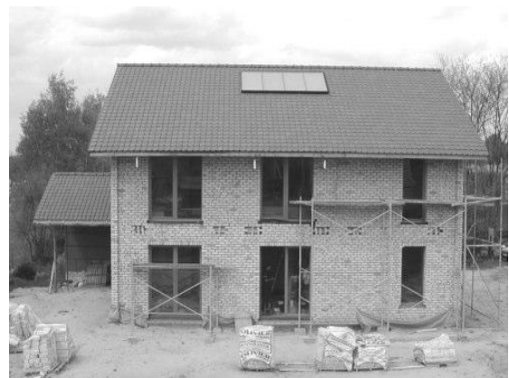
Εικόνα 3.2: Νότια όψη του υπό μελέτη κτιρίου (46)
