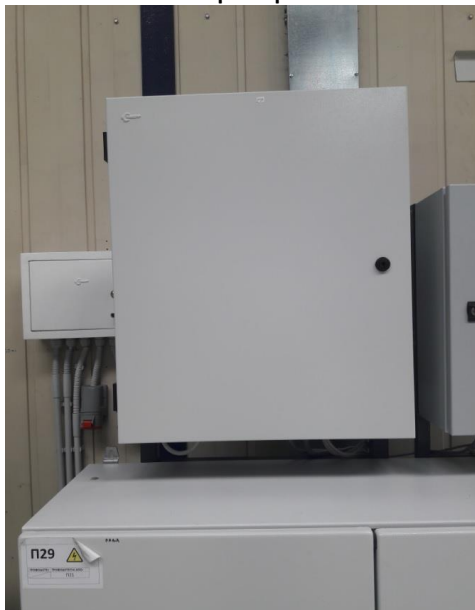
Εικόνα 274: Τοποθέτηση του πίνακα αυτοματισμού του συστήματος SCADA
