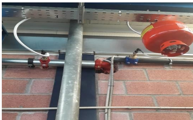
Εικόνα 52: Αριστερά αισθητήρας πίεσης, δεξιά αισθητήρας κενού προσαρμοζόμενοι στο κεντρικό δίκτυο
