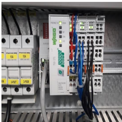
Εικόνα 60: Remote I/O για τη μεταφορά σημάτων μέσω δικτύου Profinet από τις IMM στο PLC
