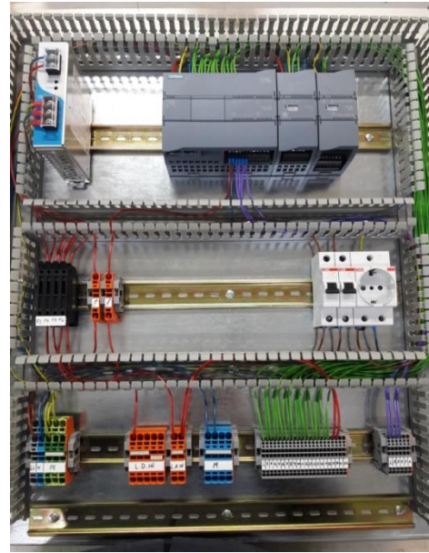
Εικόνα 273: Ολοκλήρωση εσωτερικής καλωδίωσης του πίνακα αυτοματισμού
