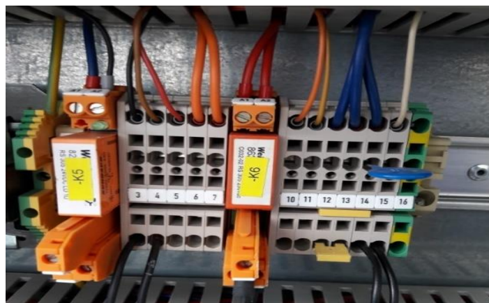
Εικόνα 51: Επαφές για σήματα λειτουργίας και βλάβης του αεροσυμπιεστή S60-2
