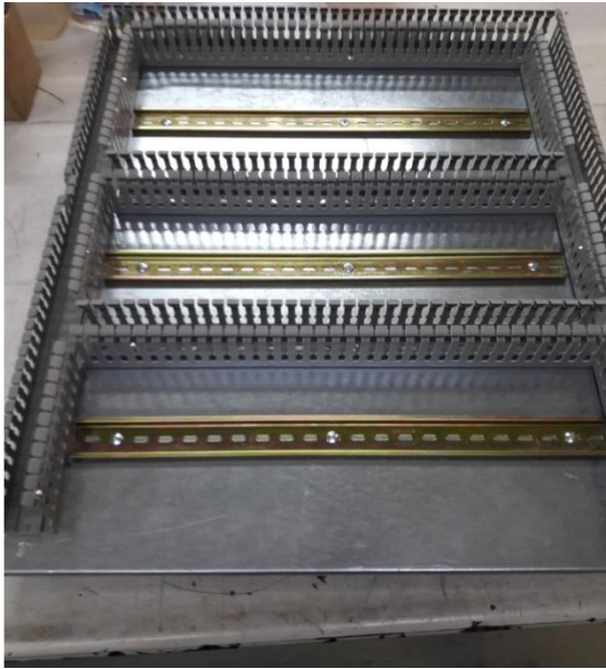
Εικόνα 272: Πρώτα στάδια κατασκευής του πίνακα αυτοματισμού
