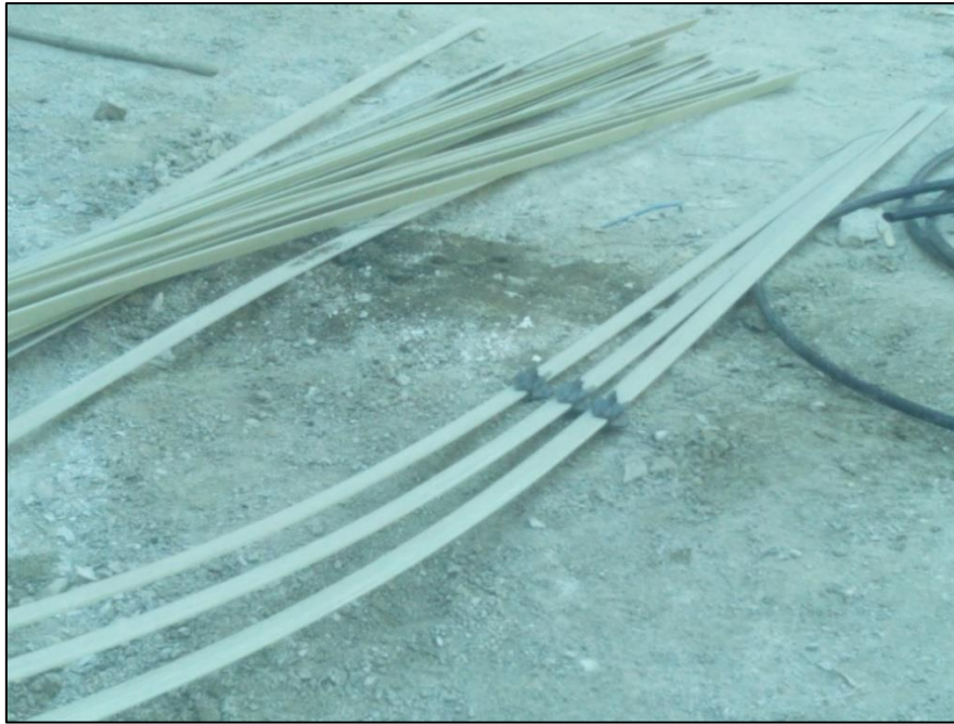
Εικόνα 24 : Αγκύρια fiberglass ορθογωνικής διατομής με κεντραδύρο (Πηγή: Γεωργίου Δ.).
