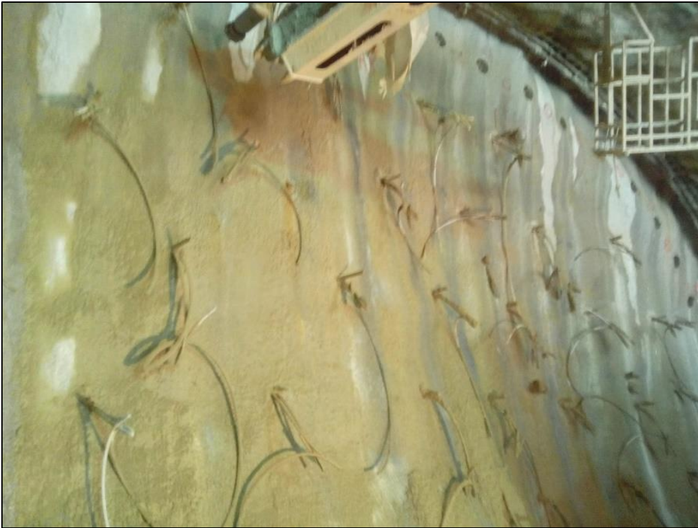
Εικόνα 23 : Μέτωπο εκσκαφής υποστηριγμένο με αγκύρια fiberglass (Πηγή: Γεωργίου Δ.).
