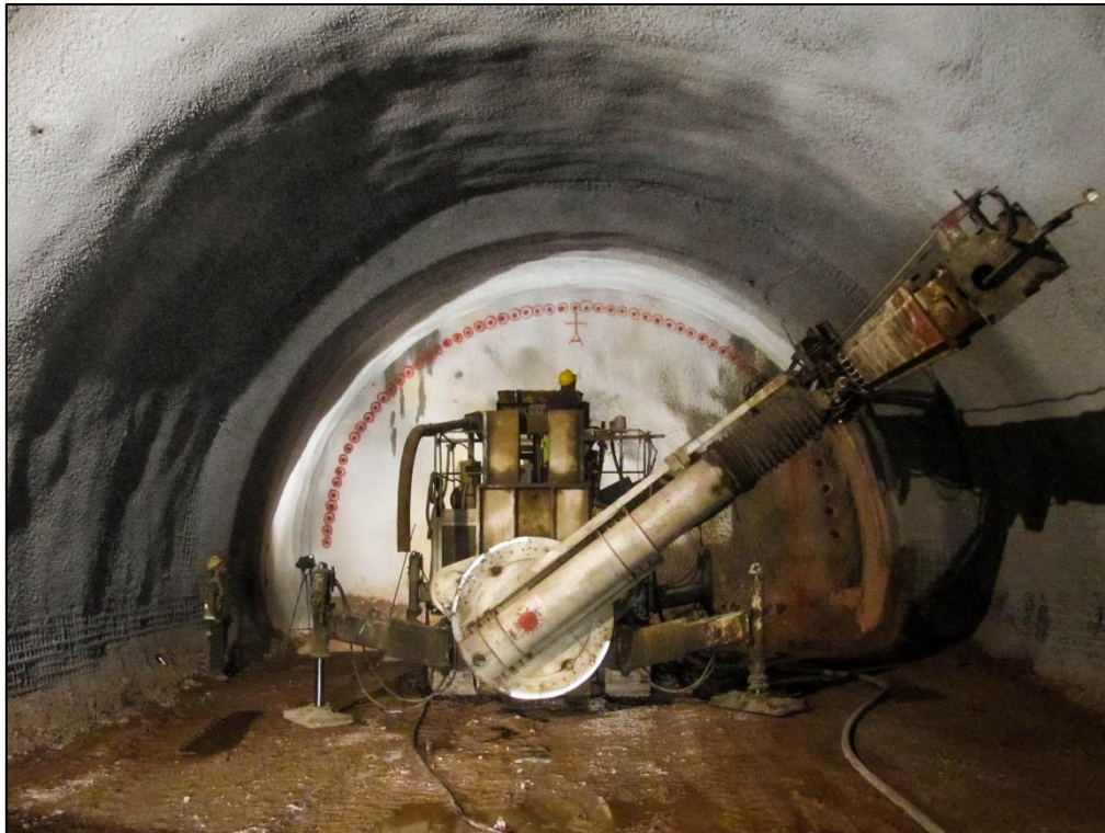
Εικόνα 20 : Διαδικασία κατασκευής ομπρέλας δοκών προπορείας (Πηγή: Γεωργίου Δ.).
