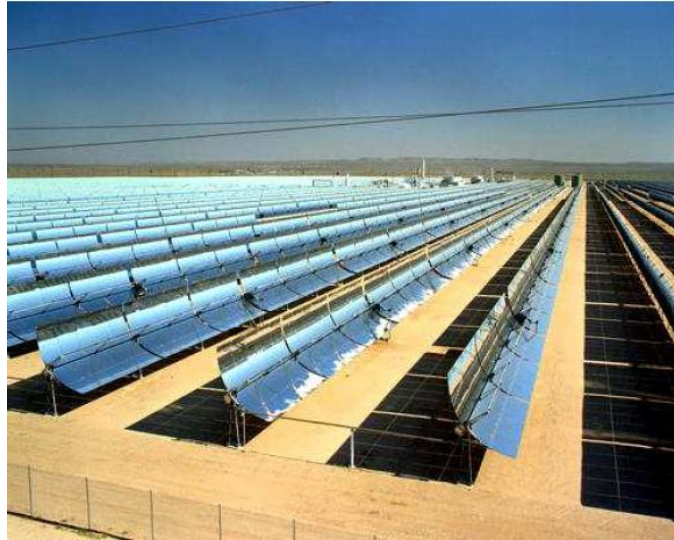
Εικόνα 3.1: Κυλινδροπαραβολικό συγκεντρωτικό σύστημα
