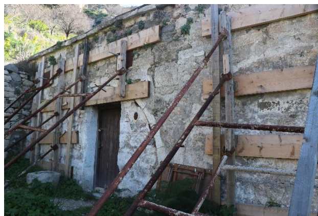
Εικόνα 45 : Απεικόνιση των εξωτερικών στηρίξεων του Αγίου Ευθυμίου
