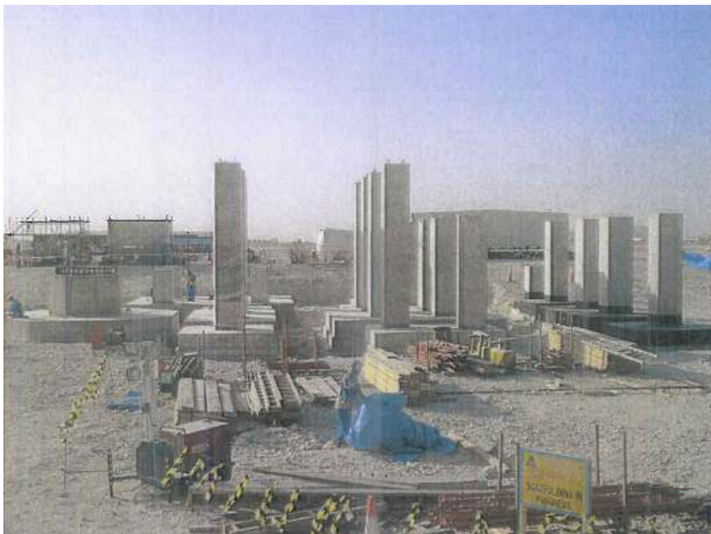
Σχήμα 6.12: Ολοκλήρωση τμήματος των θεμελίων για τον κλίβανο 1 της AC31
