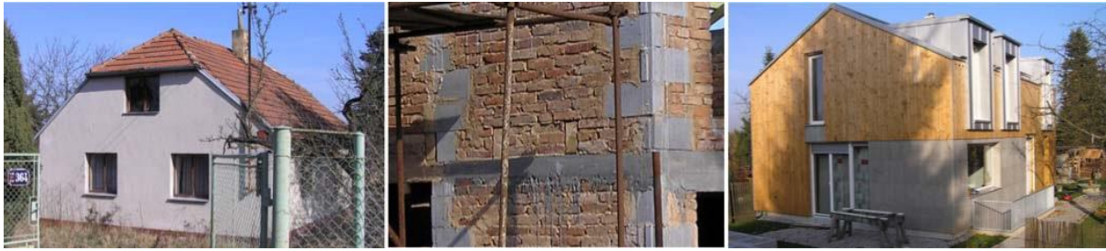
Εικ. 4.3 Αριστερά: Αρχικό κτήριο. Κέντρο: Λεπτομέρεια της δομής του εξωτερικού τοίχου - νέα στοιχεία σκυροδέματος με επαναχρησιμοποιούμενα τούβλα. Δεξιά: Τελικό κτήριο.
