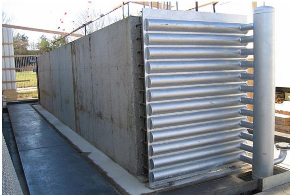
Εικόνα 3.20: Τυπικό παθητικό σύστημα αποθήκευσης με χρήση σκυροδέματος
