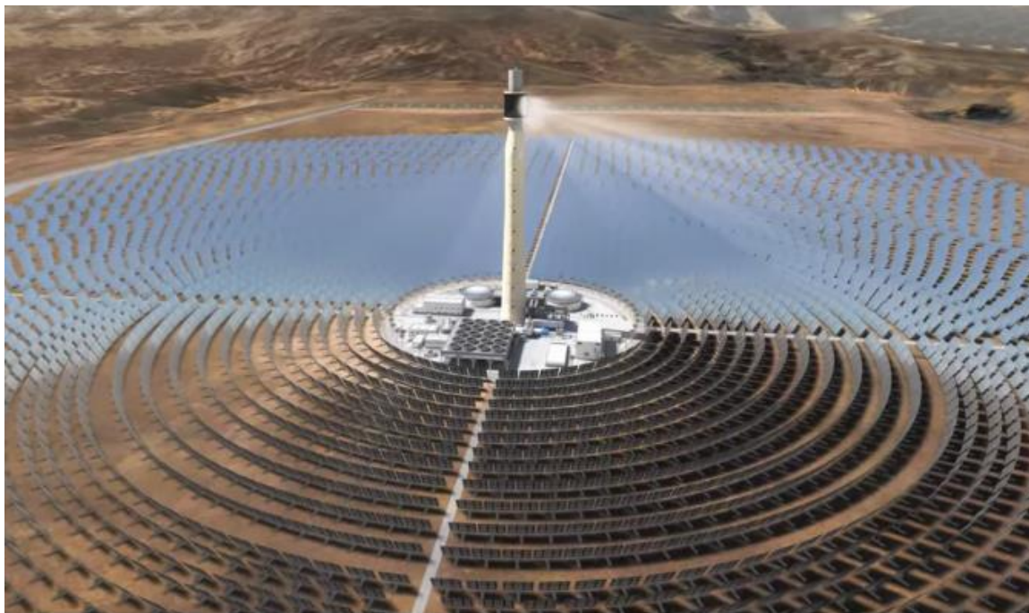
Εικόνα 1.13: Ηλιακός Πύργος Ισχύος (Solar Power Tower), Noor III, Morocco [21]
