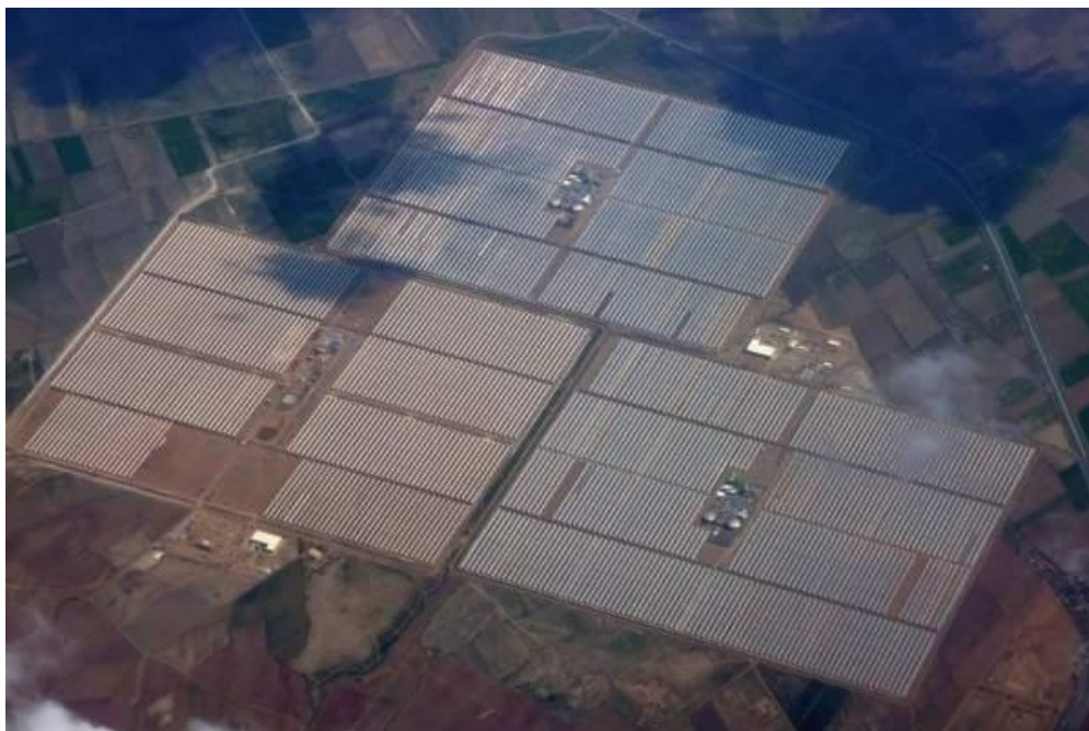
Εικόνα 1.9: Τα ηλιακά θερμικά εργοστάσια Andasol I, II και III
