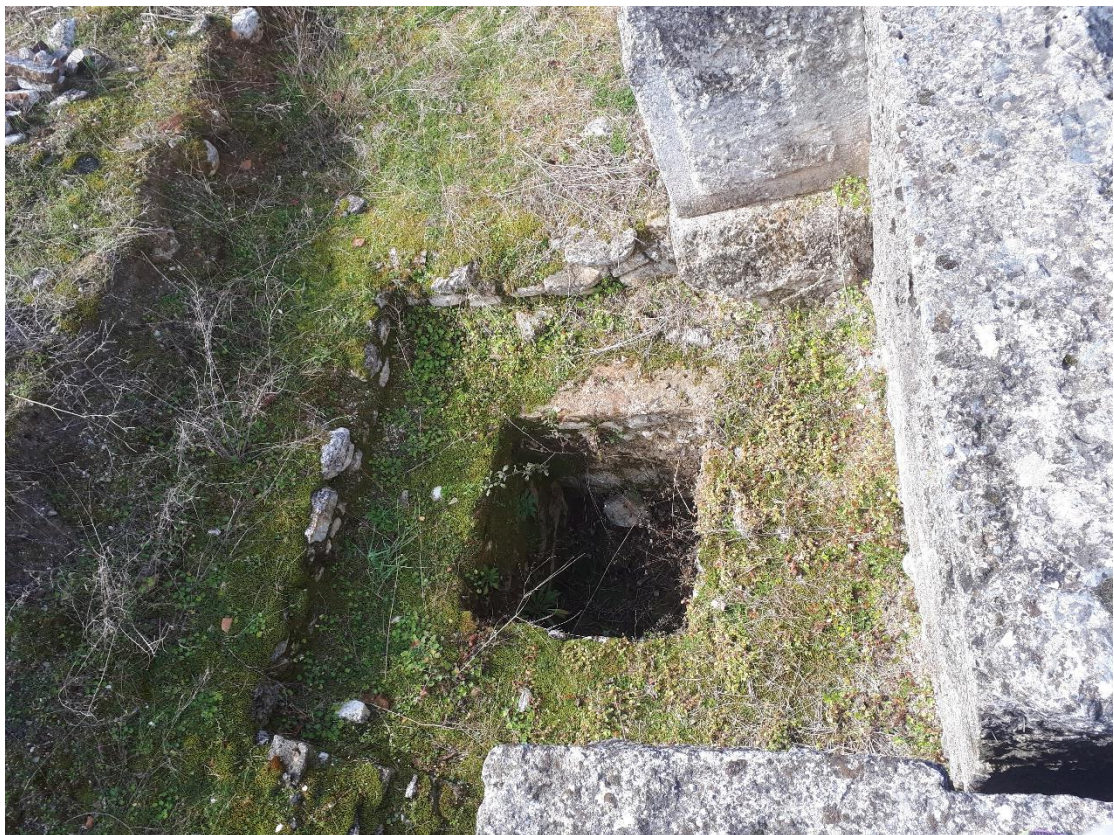
Εικόνα 16. Φωτογραφία του φρεατίου της κεντρικής δεξαμενής που παροχέτευε τα λουτρά. Πηγή: της ίδιας από προσωπικό αρχείο. Έτος 2019.
