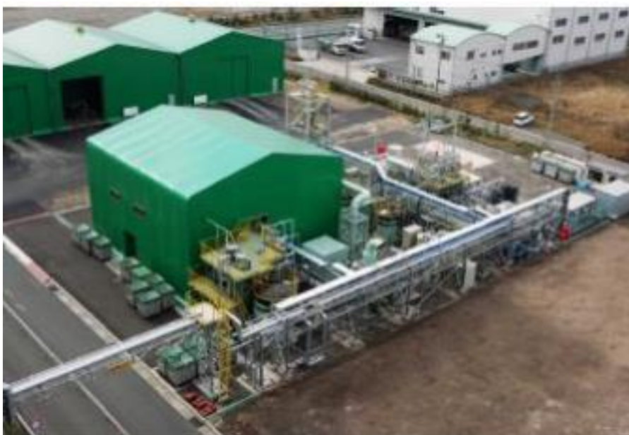
Εικόνα 8. Εργοστάσιο επεξεργασίας διατροφικών απορριμμάτων για την παραγωγή βιοαιθανόλης (Nippon Steel Engineering Co., Ltd.)( IGES Policy Report 2011-02).
