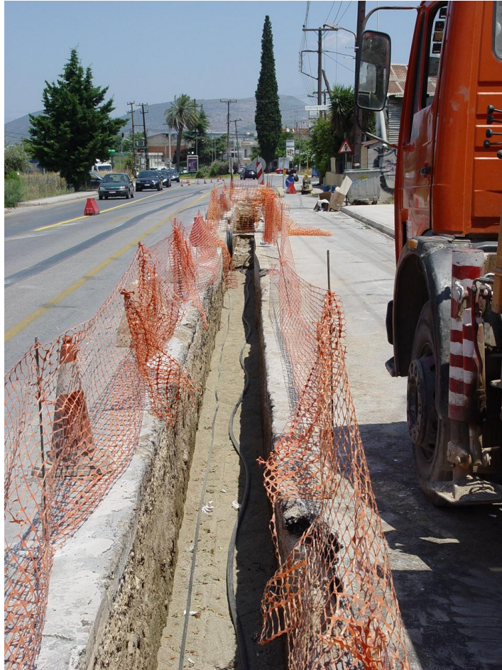
Εικόνα 6 – 4. Άλλη άποψη της εγκατάστασης του Αγωγού Φυσικού Αερίου Μέσης Πίεσης στην πόλη της Χαλκίδας (περιοχή Καστέλλα)
