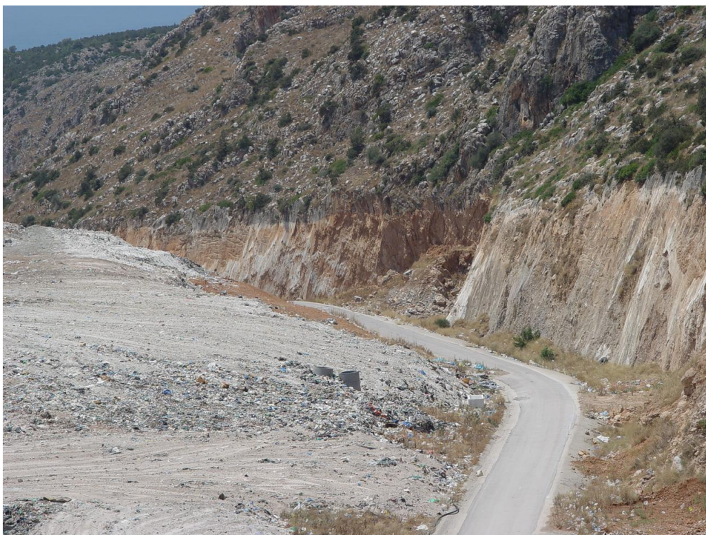
Εικόνα 7 - 4. Άποψη της κατοπτρικής επιφάνειας του μεγάλου κανονικού ρήγματος μέσα στο χώρο του ΧΥΤΑ Χαλκίδας
