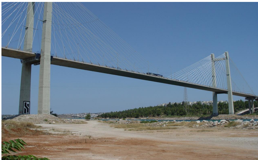
Εικόνα 4 - 2. Η Υψηλή Γέφυρα Ευρίπου με τους δύο κεντρικούς πυλώνες M5 (στην Στερεά Ελλάδα – αριστερά) και M6 (στην Εύβοια – δεξιά)
