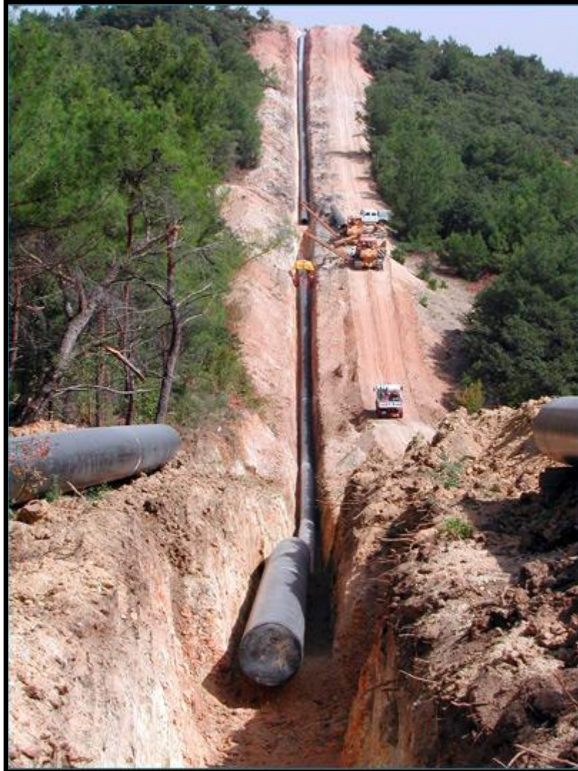
Εικόνα 6 - 1. Τοποθέτηση Αγωγού Φυσικού Αερίου Υψηλής Πίεσης ( www.depa.gr )
