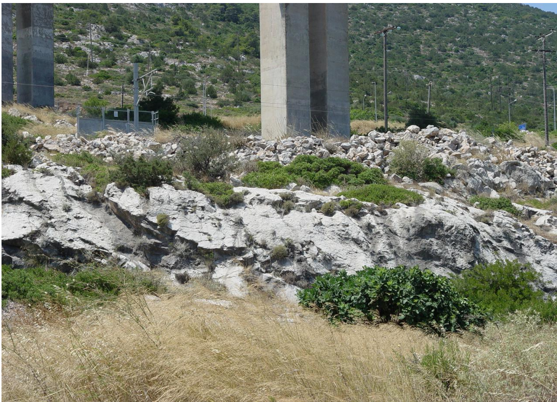
Εικόνα 4 - 7. Ασβεστόλιθοι Ανωτριάδικής – Κατωιουρασικής Ηλικίας (στη Βοιωτική πλευρά θεμελίωσης)
