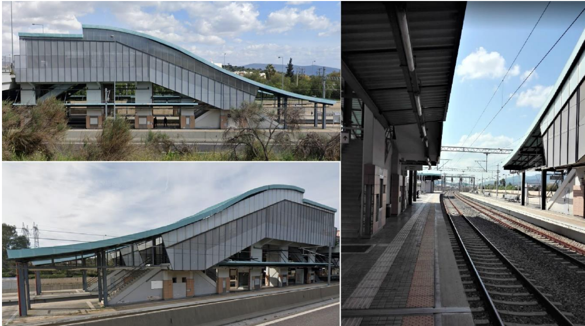
Εικόνα 2.18: Σταθμός «Μαγούλα» Προαστιακού Σιδηροδρόμου, Χαρακτηριστικές Φωτογραφίες σταθμού
